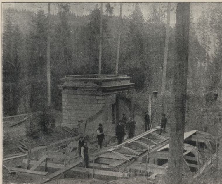
Rys. 2. Budowa drugiej komory przy zbiorniku wodociągowym w Krynicy.
