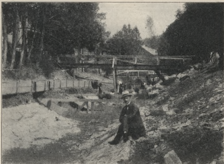
Rys. 5. Żłób Kryniczanki w toku budowy.
