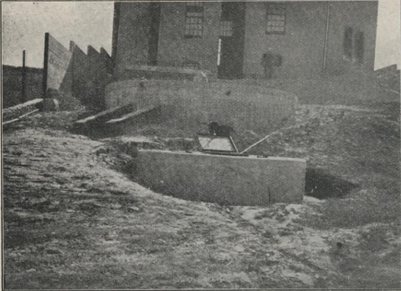
Figur 20. Blick auf die Reinigungsanlage in Langendreer; oben sieht man den Emscherbrunnen, unten den Sickerbrunnen.
