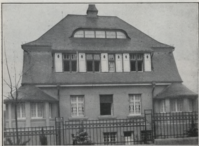
Abb. 13. Steiles Dach mit altdeutscher Deckung
