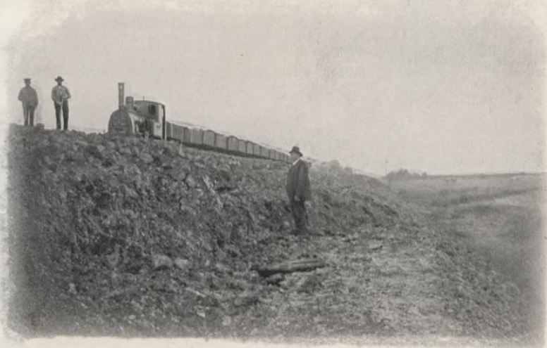
Schüttung des neuen Schutzdeiches mit Kippwagen.
