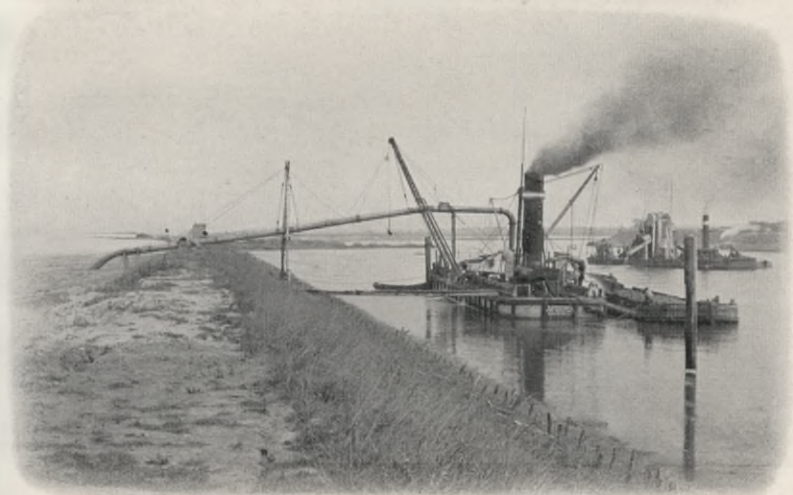
Schutensauger, Baggerboden hinter den westlichen Spüldeich von Becken III spülend; weiterhin Eimerbagger bei der Arbeit.
