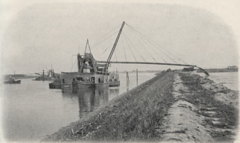
Elevator, Baggerboden hinter den östlichen Spüldeich von Becken III schüttend.
