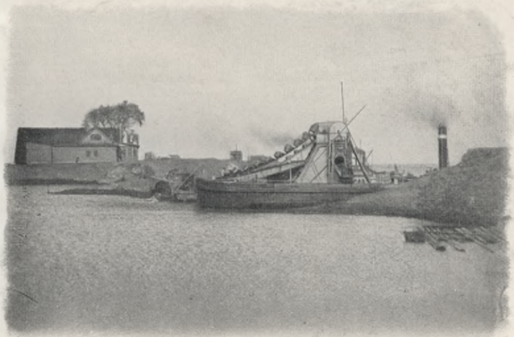
Durchbrechung des alten Elbdeiches in Becken I mit Eimerbagger von der Elbe her.
