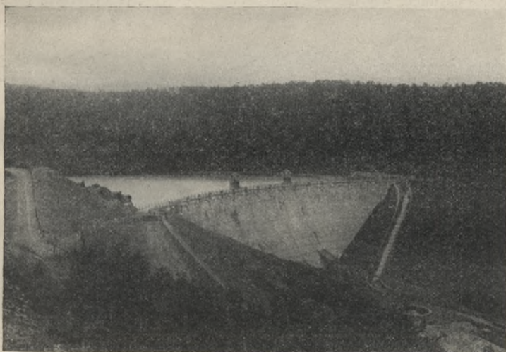
Abb. 6. Sengbachtalsperre bei Solingen. Hauptsperrmauer. Dezember 1903.
