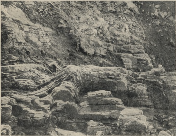
Abb. 2. Faltung der Gesteinschichten an der Baustelle der Hennetalsperre bei Meschede a. d. Ruhr.
