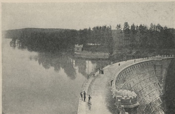
Abb. 18. Talsperre bei Marklissa. Oberansicht der Mauer (Becken gefüllt).
