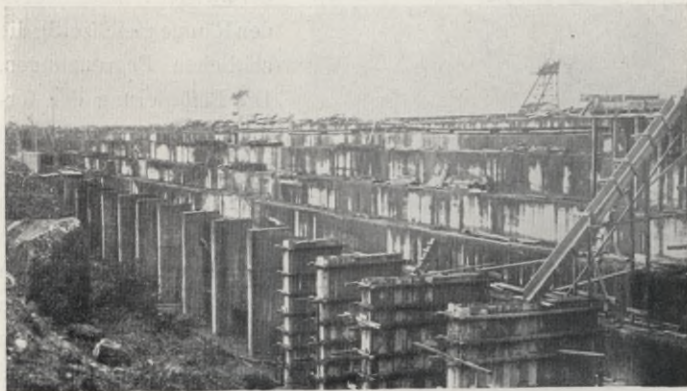
Abb. 34. Außenansicht der Schleusenmauer mit Pfeilern für die Auflagerung der Drainagekanäle.
