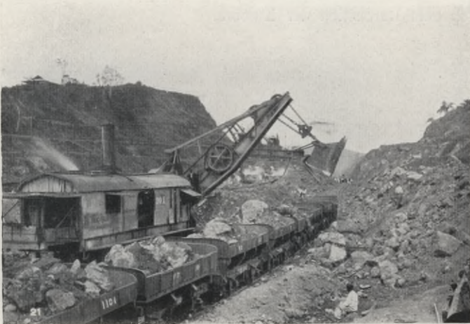
Abb. 16. Dampfschaufel nach Entleerung des Kübels über dem Förderwagen.
