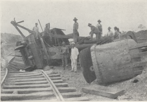
Abb. 15. Umgestürzte Dampfschaufel.
