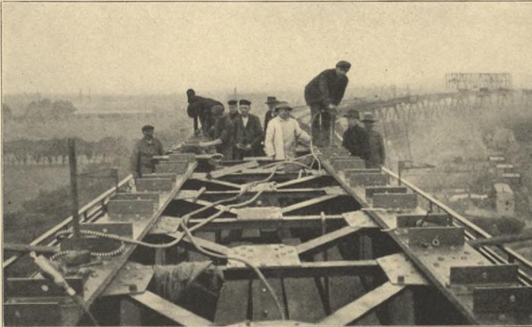
hierzu waren einschließlich des Verlegens der Fahrbahn durchschnittlich sechs Stunden nötig. — Die Fußwege und Randträger wurden mittels eines leichten, nach beiden Seiten überragenden Bockkranes
