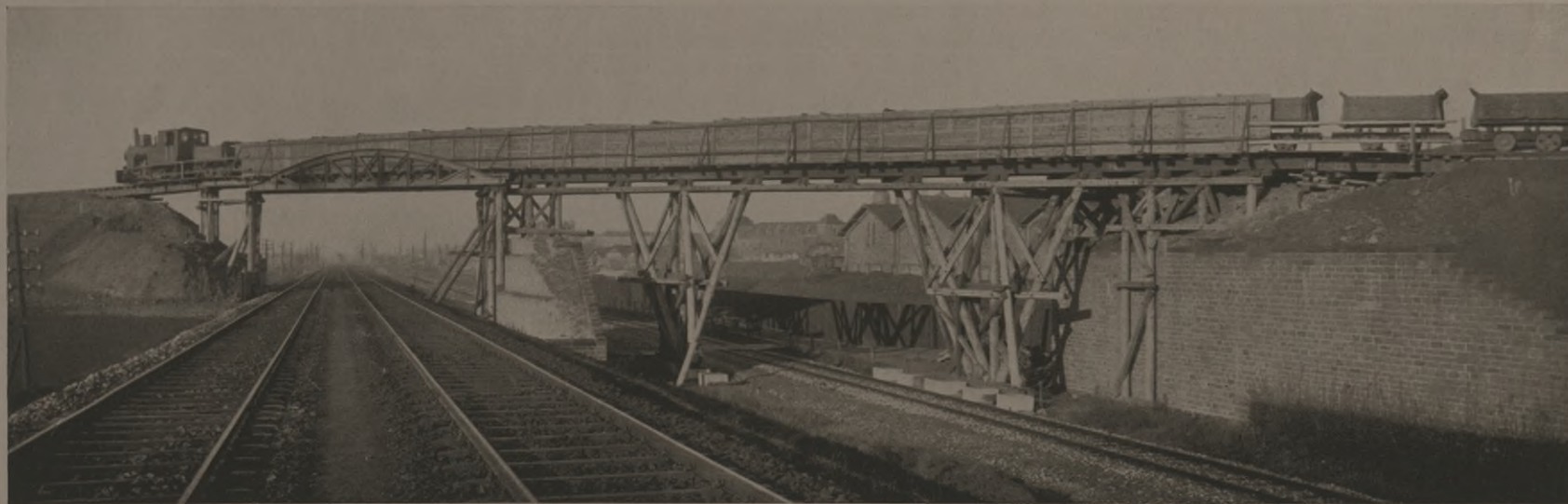
Ueberführung der Materialtransportbahn über die Hochbahn Karlsruhe-Durlach
