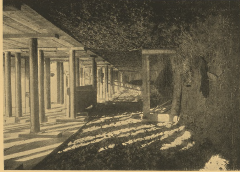
Ausgehobene Baugrube mit Aushubschablone und Absteifung
