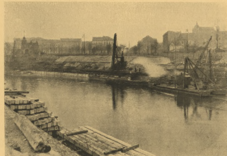
Rammen der Spundwand
