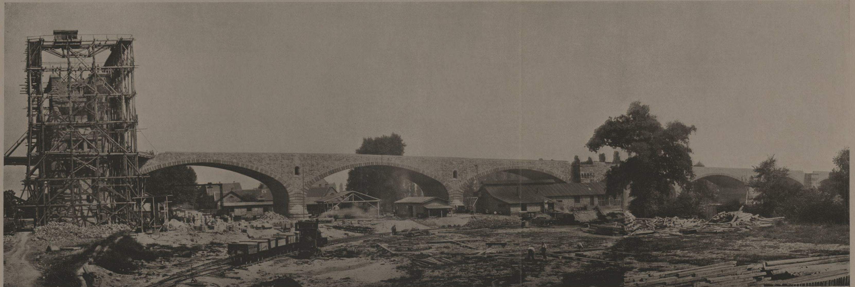
Rechtsseitiger Torturm und anschließende Flutöffnungen im Bau
