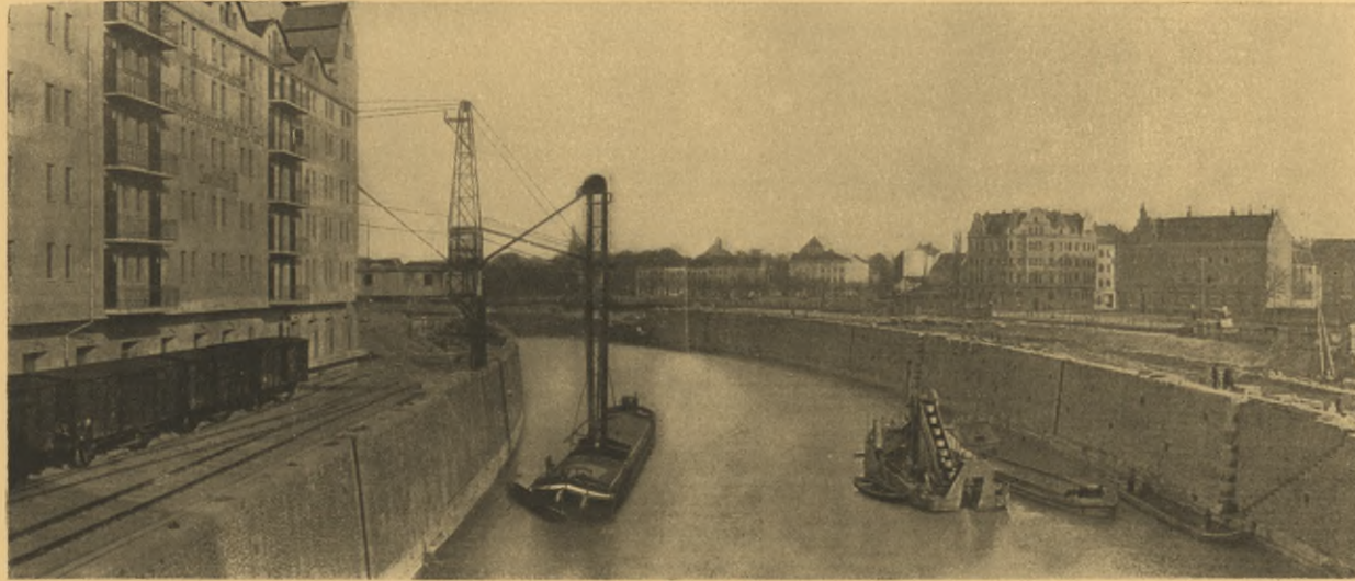
Petroleumhafen mit stadt- und rheinseitiger Ufermauer
