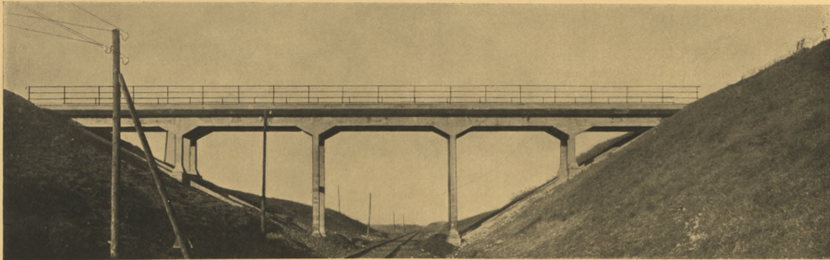
Eisenbahnbrücke in Eisenbeton bei Dittelsheim-Heßloch der Eisenbahnlinie Osthofen-Gaudernheim
