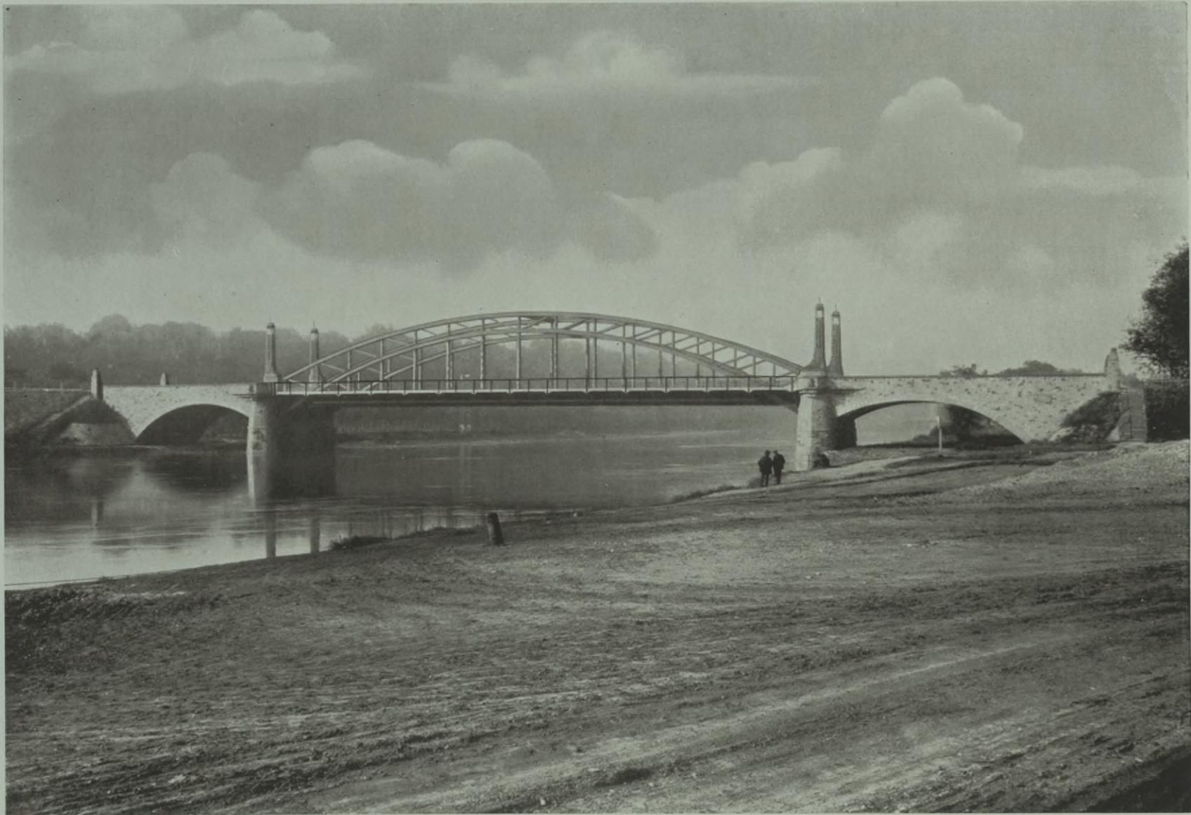
Straßenbrücke über die Saale bei Bernburg
