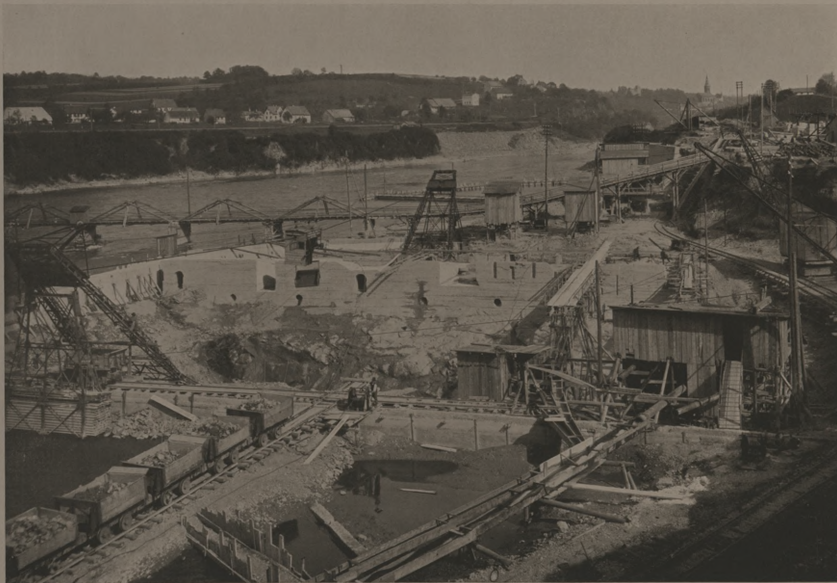
Landseitige Baugrube des Krafthauses während des Baues (Foundation des Turbinenhauses)
