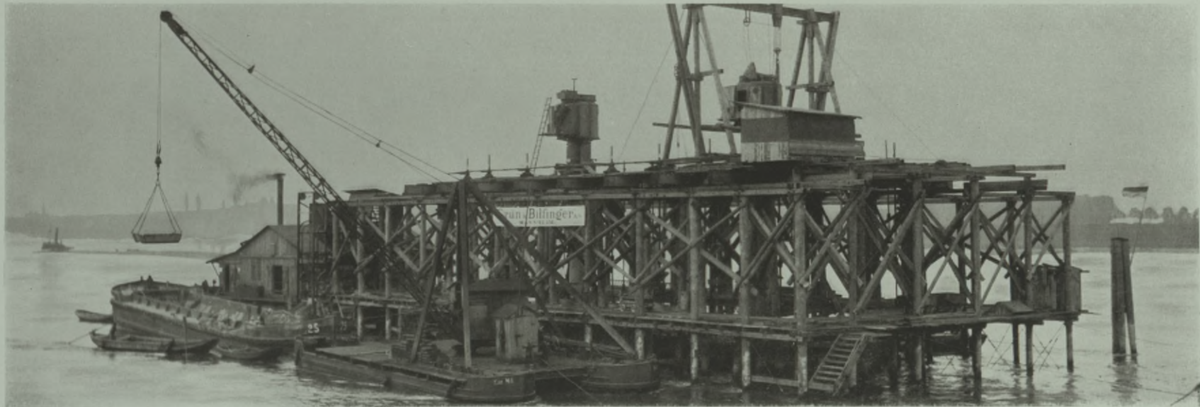
Caissongerüst eines Strompfeilers mit eingehängtem Senkkasten Eisenbahnbrücke über den Rhein bei Cöln (Südbrücke) Erbaut im Auftrag der Kgl. Preuß. Eisenbahndirektion Cöln 1907/09
