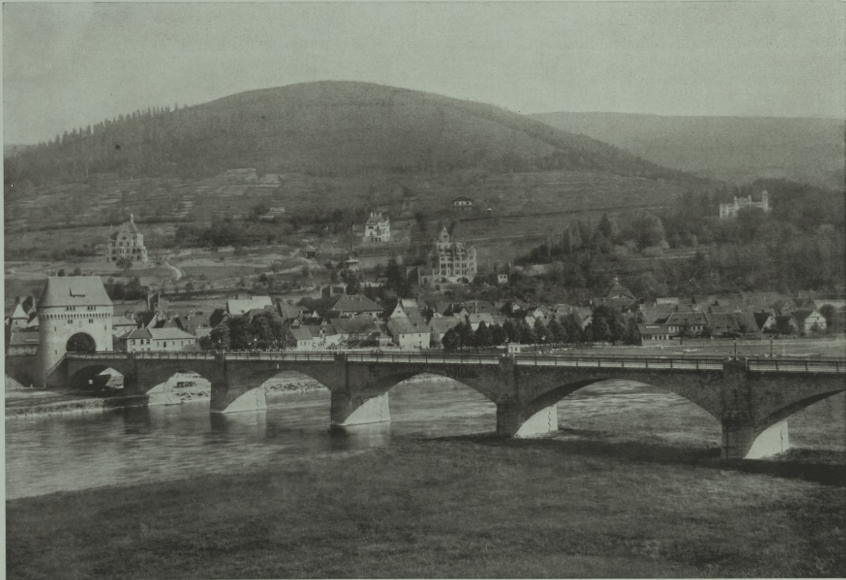
Straßenbrücke aus Stein über den Main bei Miltenberg (mit Gelenkbogen)
