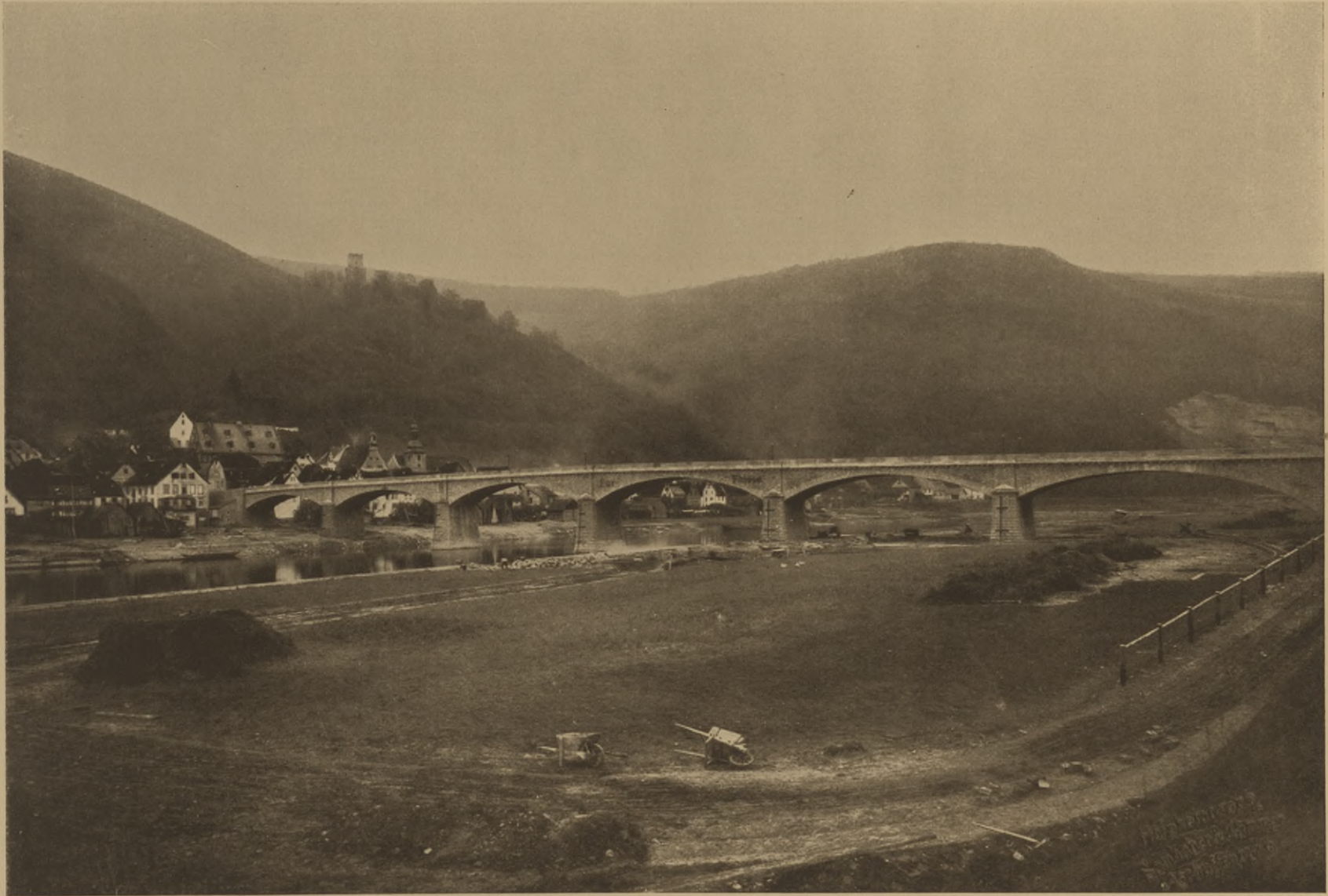
Straßenbrücke aus Stein über den Main bei Freudenberg
