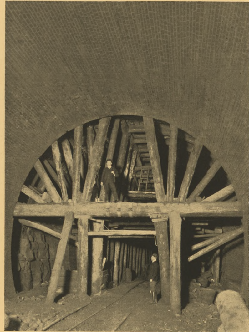
Fertige Tunnelzimmerung durch den sog. Distelrasen
