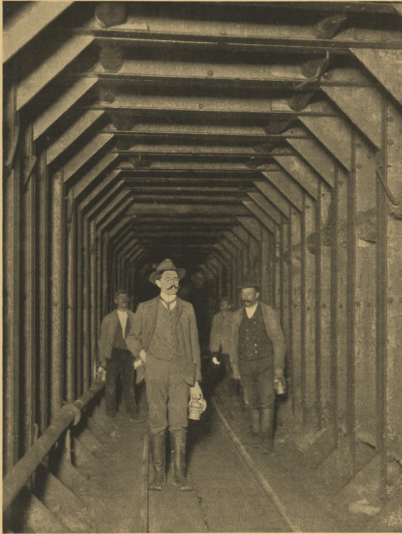
Mit Eisenrahmen ausgebaute Stollen in druckhaftem Gebirg
