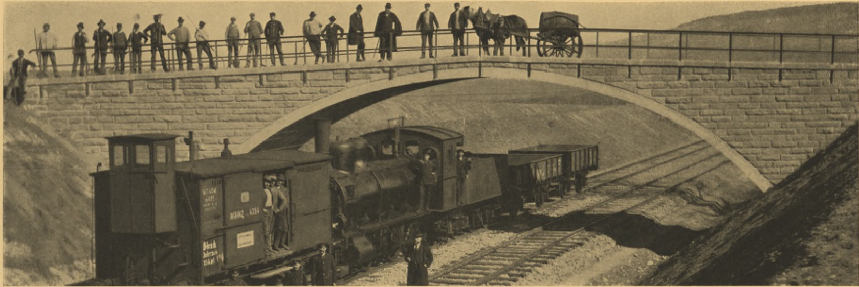
Feldwegüberführung auf der Eisenbahnlinie Gausalgesheim-Münster a. St.
