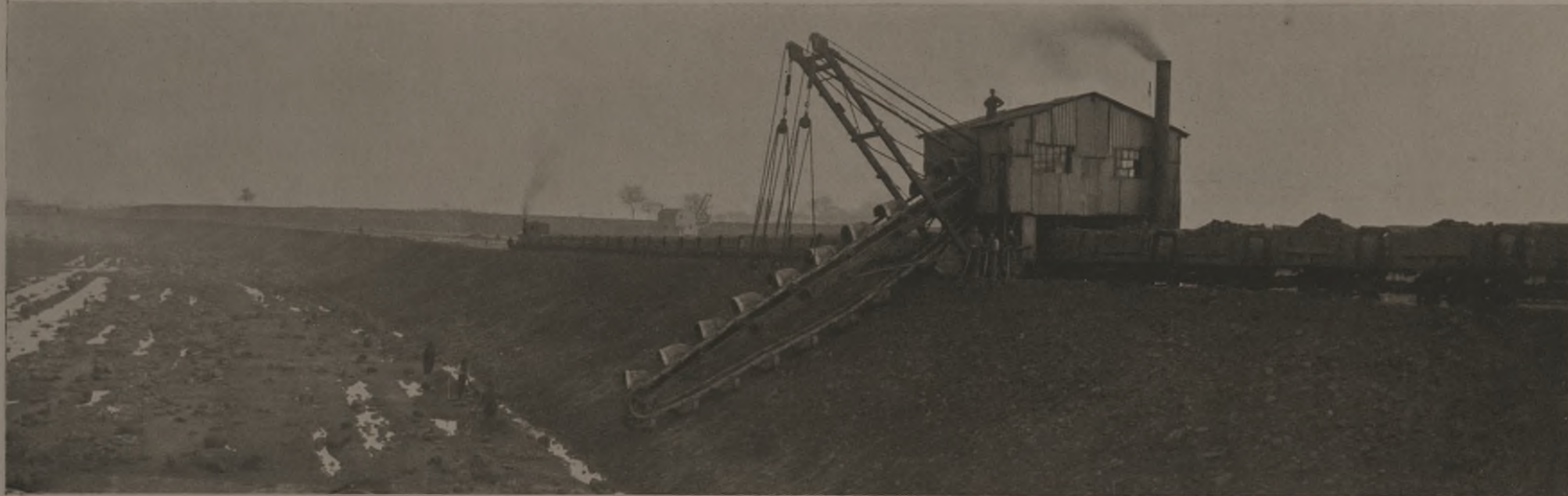
Erdbewegung mittels Trockenbaggerung
