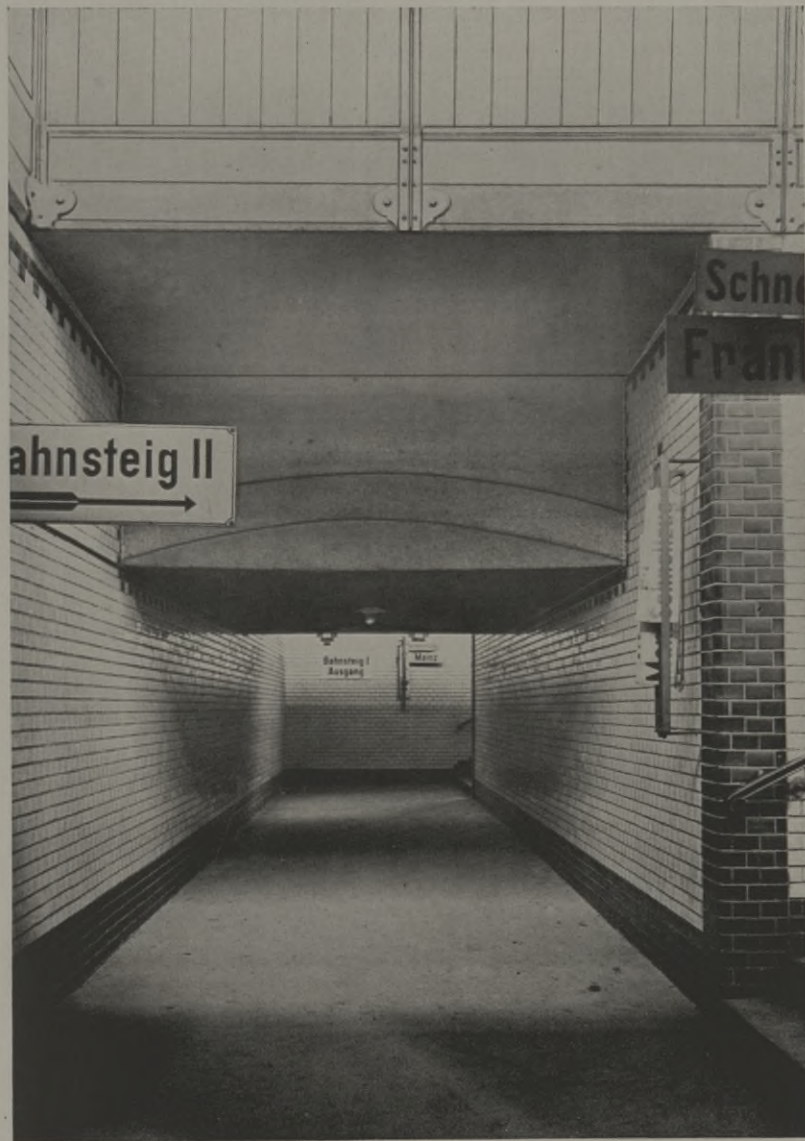
Bahnsteigtunnel in Eisenbeton auf Station Dornberg-Gr. Gerau Ausgeführt 1906 im Auftrag der Kgl. Preuß.-Großh. Hess. Eisenbahndirektion Mainz
