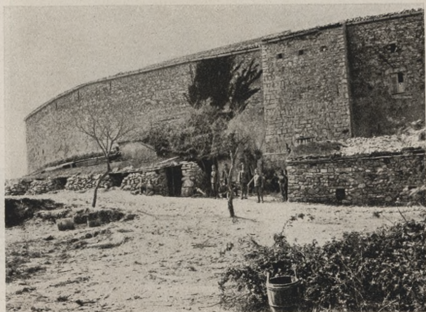
Altes Gebäude nahe der Käfte
