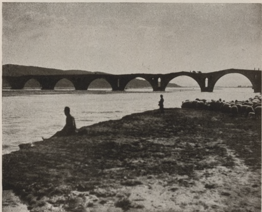
Alte türkische Brücke bei Elbaffan
