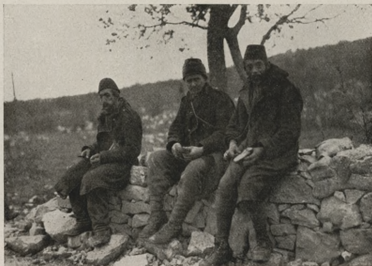
Bosnische Strafsenarbeiter im Karst. Aufnahme Capt. Kleinschmidt
