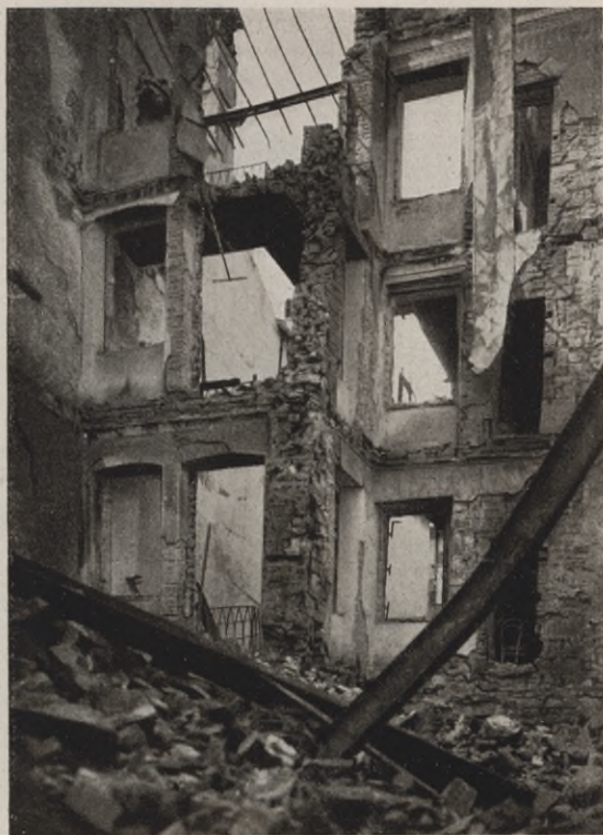
Haus der Herrengasse in Görz. Aufnahme Ldft.-Ing. Rösler
