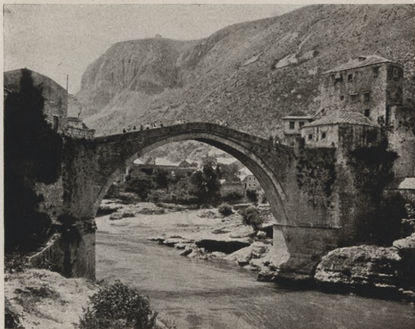
Mostar, alte türkische Narentabrücke (Bogen von 28 m Spannweite und 19 m Höhe), etwa 16. Jahrh. Aufnahme Reiffenstein
