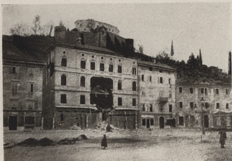
Straße im zerstörten Görz
