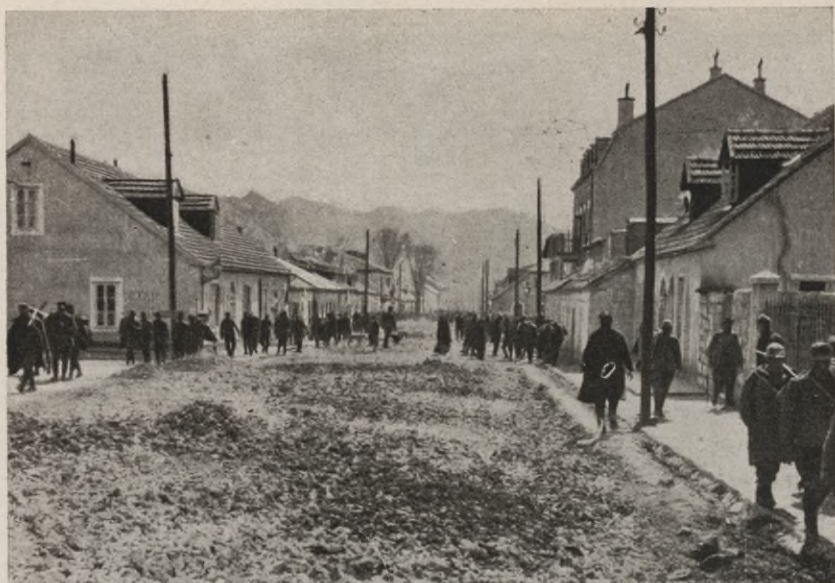
Die österr.-ung. Verwaltung läßt die Hauptstraße von Cetinje ausbessern Aufnahme Jof. Letzter
