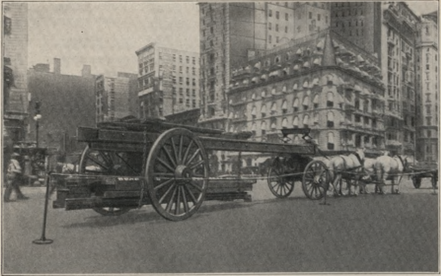
Abb. 207. Beiführen von Eisenkonstruktionsgliedern.
