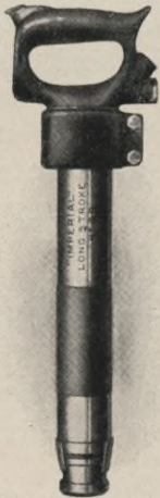
Abb. 214. Pneumatischer Niethammer.
