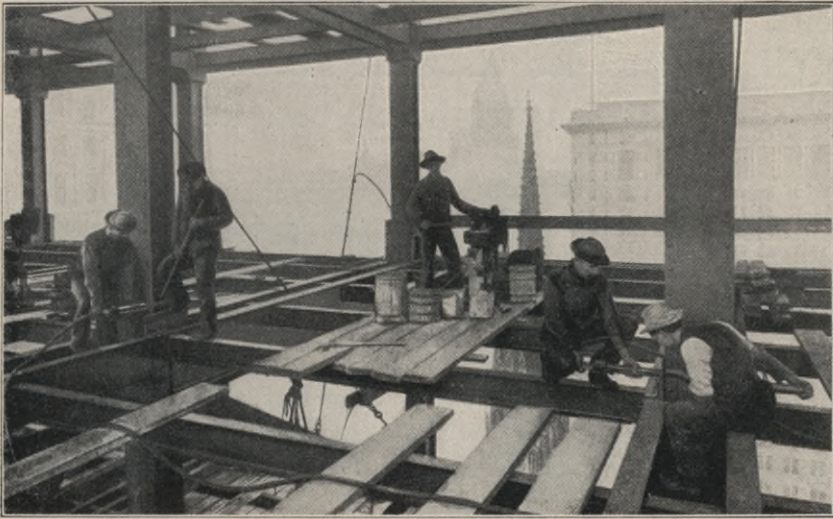
Abb. 215. Pneumatische Nietung.
