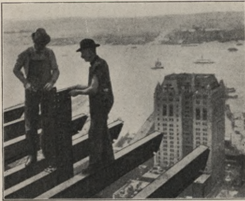
Abb. 213. Montage am Singer Gebäude. Im Hintergrunde das West Street Gebäude.
