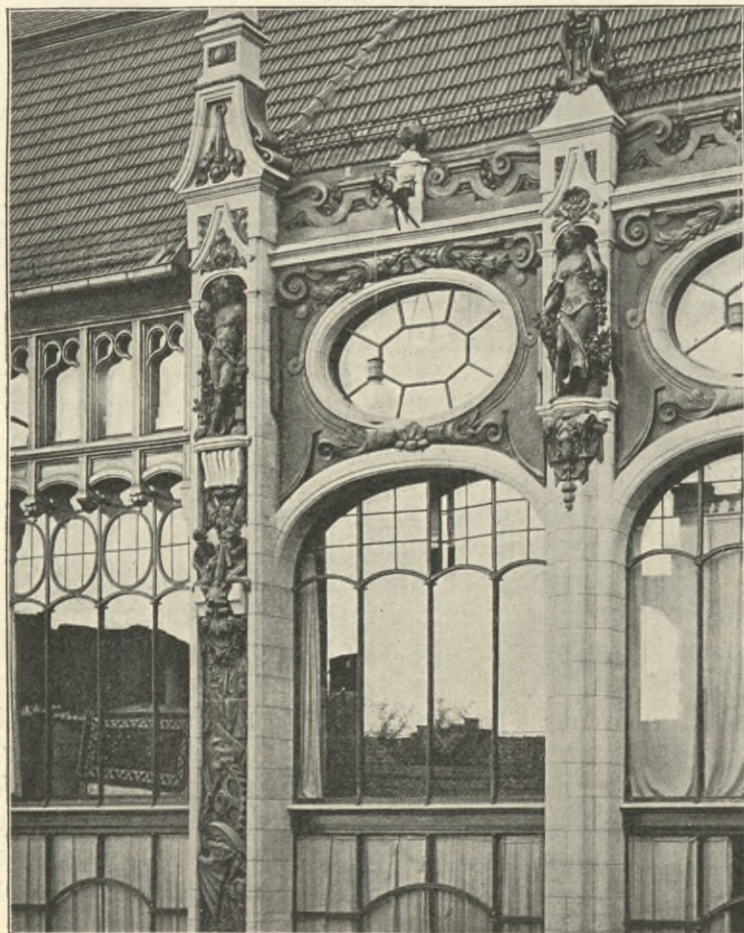
Detail des Kaufhauses Wertheim, Berlin. Architekt: Alfred Messel.
