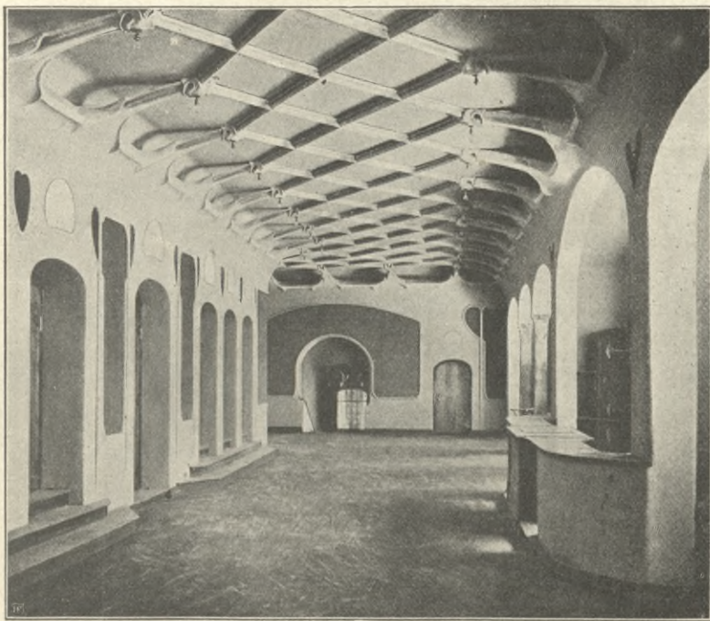
Foyer des Münchener Schauspielhauses. Architekt: Rich. Riemerschmid.
