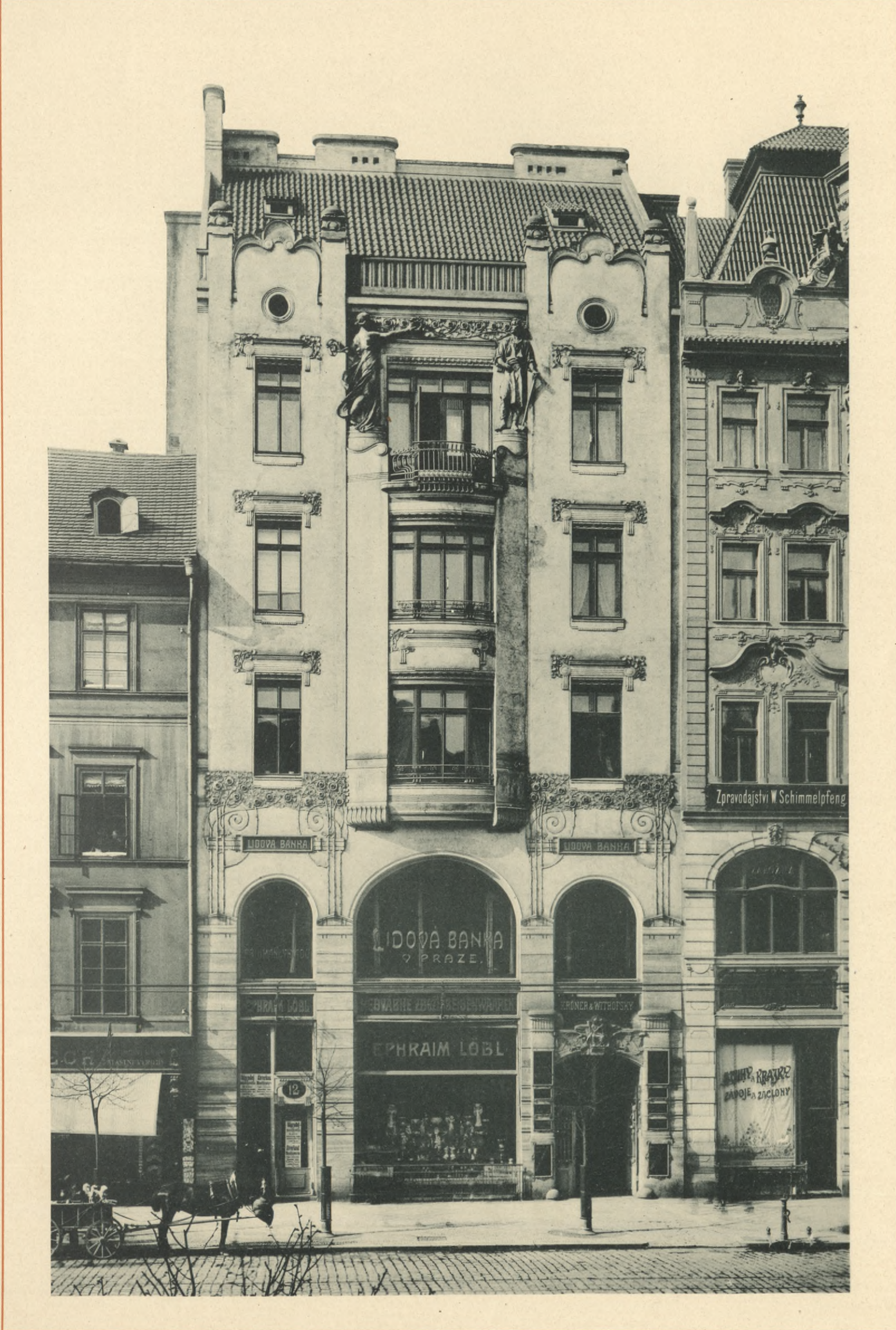
ARCHITEKT: J. KOTĚRA — PRAG
