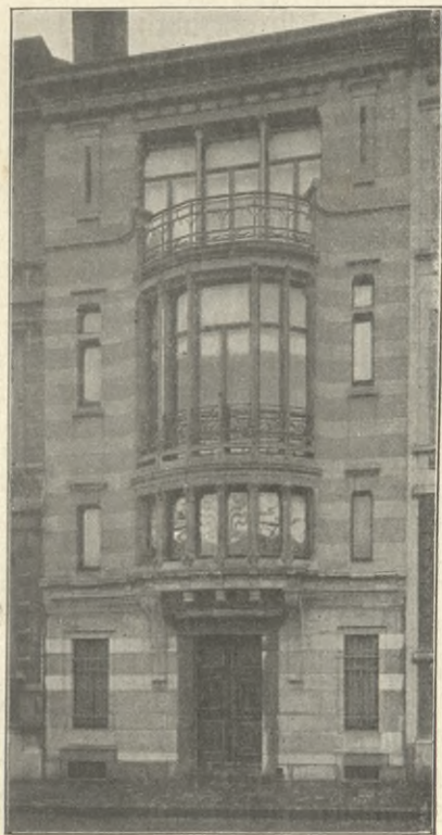
Architekt: D. Horta — Brüssel.
