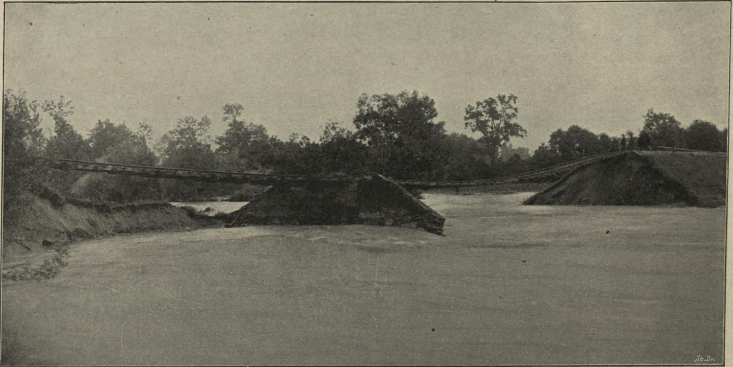
Zerstörung des Bahnkörpers und des gewölbten Durchlasses bei Ditzfurth durch die Mattig.
