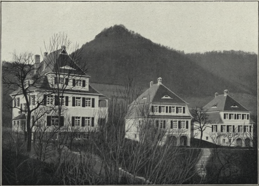
Eisenlohr & Weigle, Kgl. Oberbauräte, Stuttgart: Wohnhäuser der Ersten deutschen Kunstdruckpapierfabrik Carl Scheufelen in Oberlenningen
