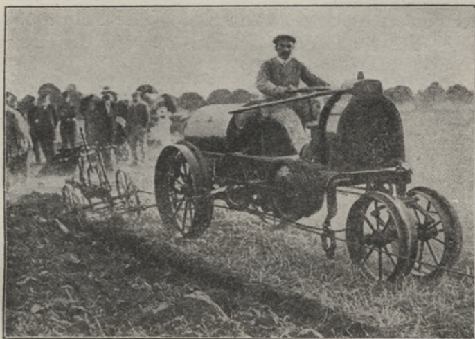
Abb. 2. Landwirtschaftlicher Traktor von de Dion & Bouton (Drehbare Vorderachse).
