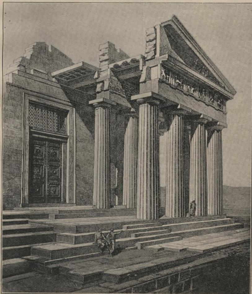
Fig. 23. Aufbau einer Ecke des Parthenon.
