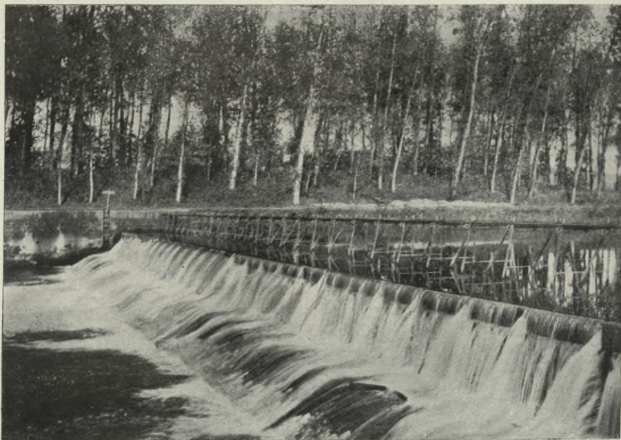
FIG. 219. — Chiusa mobile sulla Marna a Basses-Fermes. Parte provvista di paratoie Louiche-Desfontaines.
