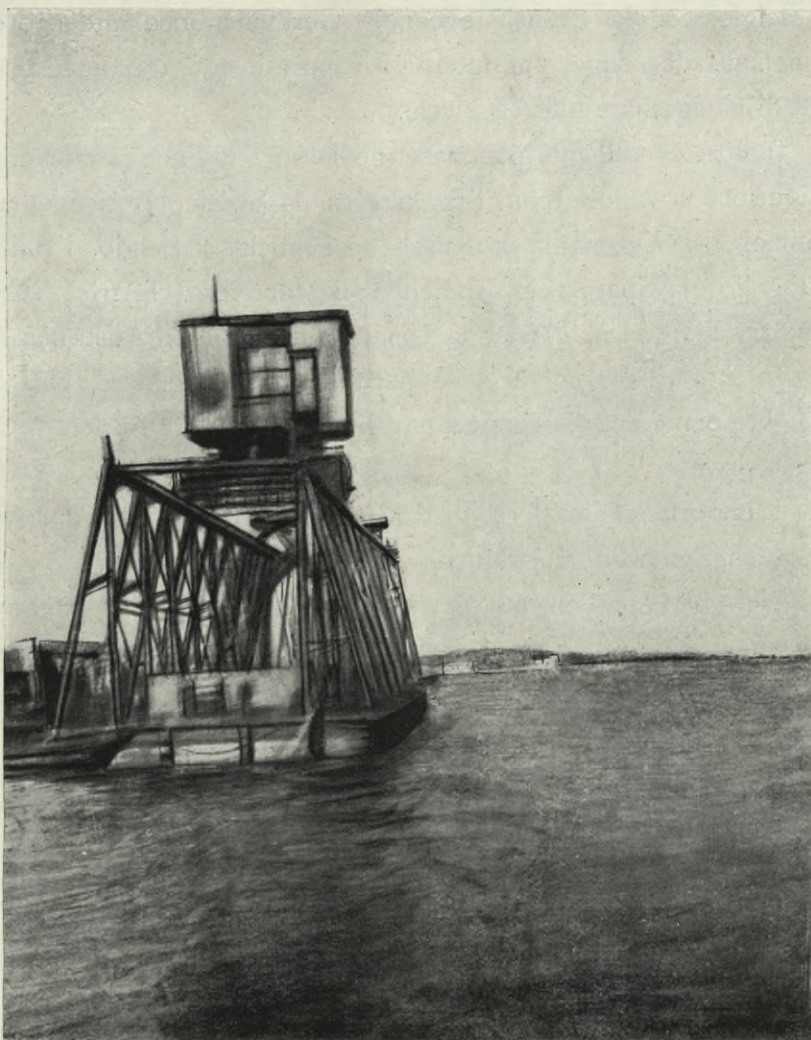
FIG. 151. — Biga galleggiante per la posa dei blocchi di calcestruzzo per i muri di banchina nel porto di Rotterdam.
