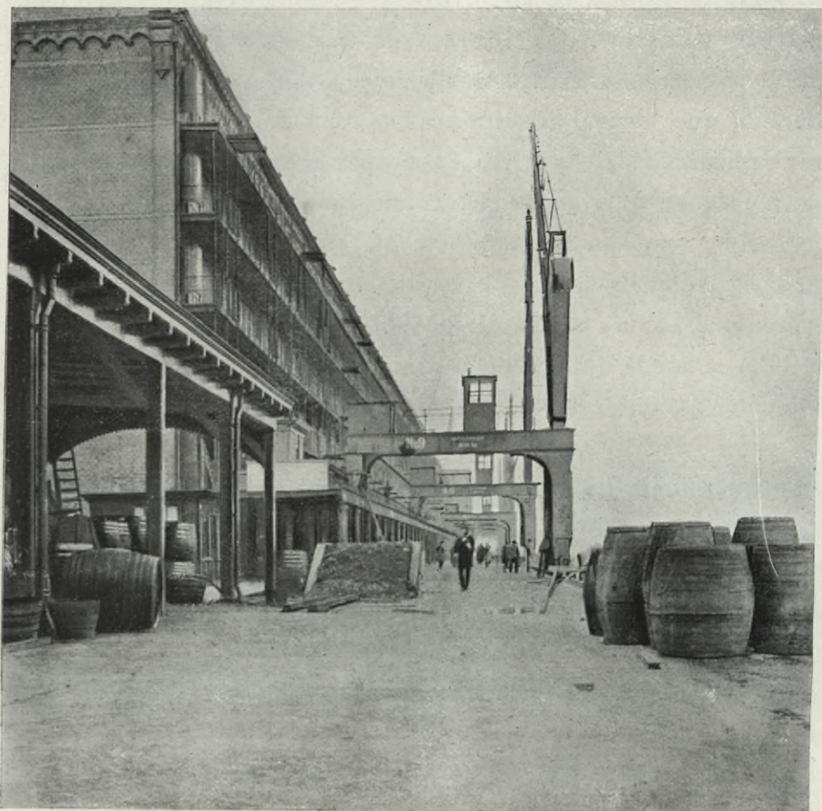
FIG. 156. — Magazzino nel porto franco di Amsterdam.
