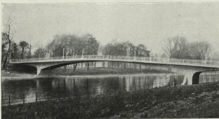
FIG. 210. — Ponte di cemento armato sul ramo destro della Mosa a Liegi.
