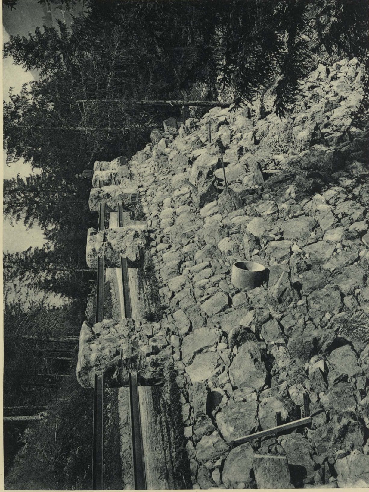
Stützmauer mit Brüstung zwischen km 49,8 und 49,9.
