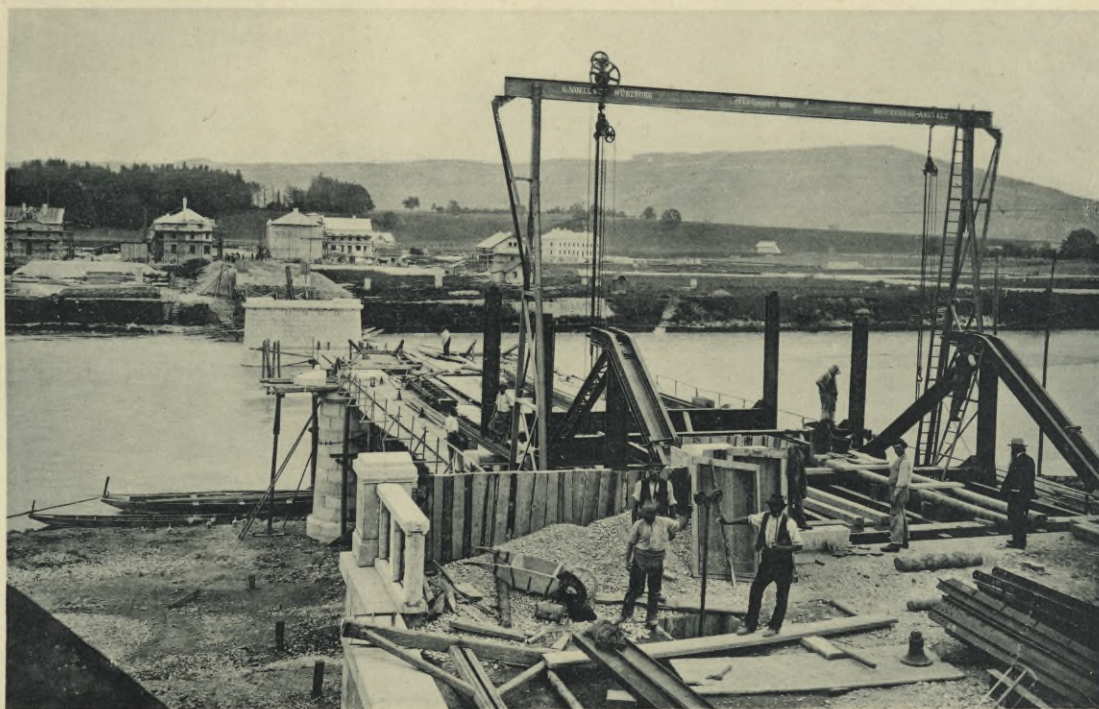
Bauzustand Ende Juli 1902.
