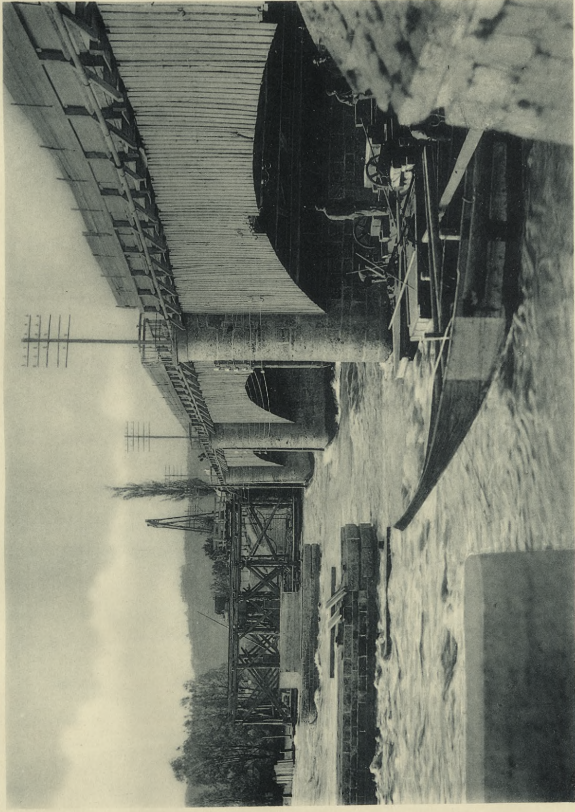
Alte Brücke und Pfeilergründung für die neue Brücke.
