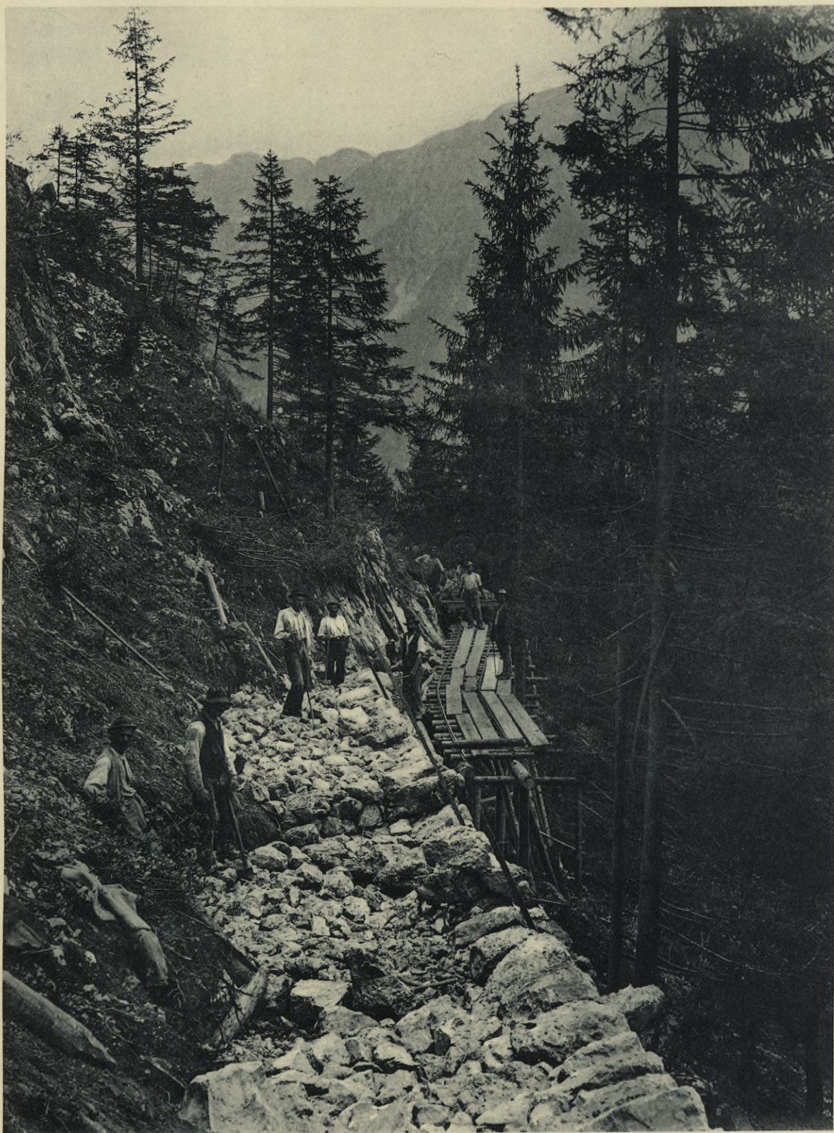
Ausführung der Stützmauer bei km 49,75.
