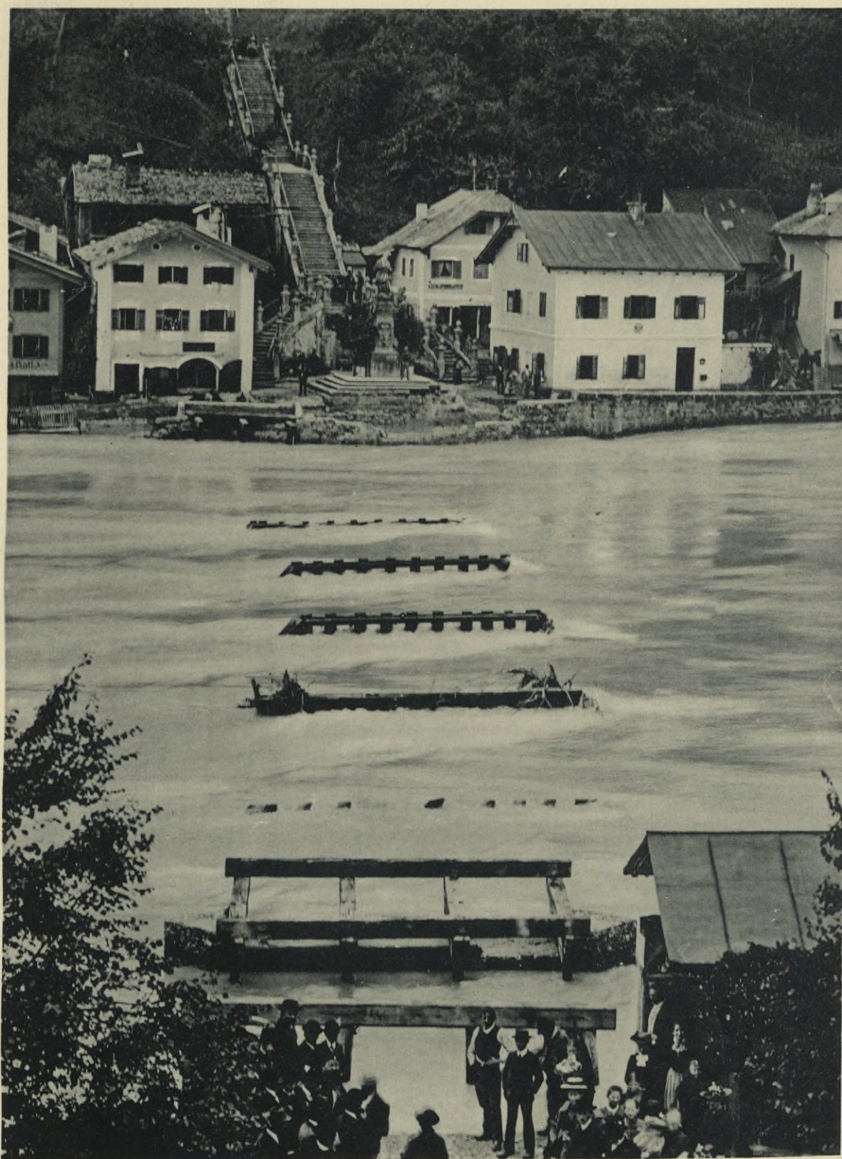
Die zerstörte alte Holzbrücke während des Hochwassers 1897.
