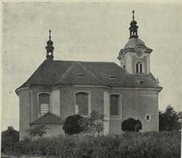
Obr. 105. Pavlíkov. Pohled na fil. kostel. sv. Kateřiny.
