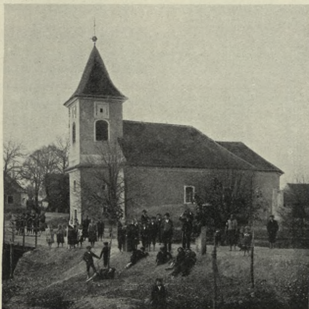
Obr. 65. Nesuchyně. Fil. kostel sv. Markety.
