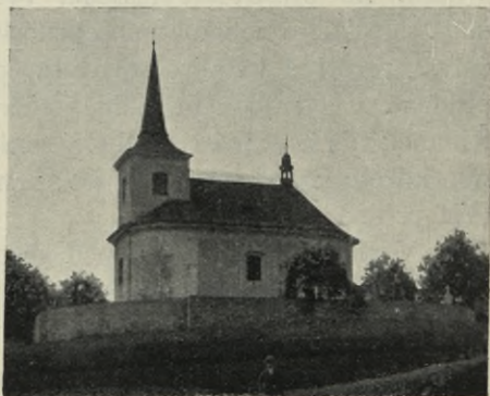
Obr. 38. Krupá. Pohled na filiál. kostel sv. Gotharda.
