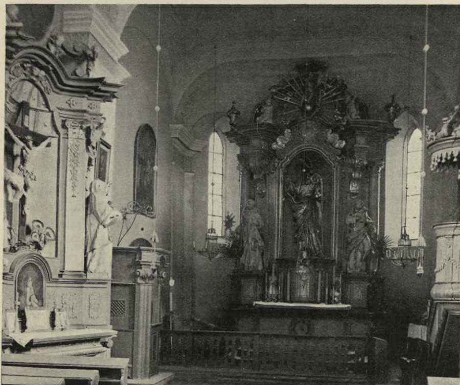
Obr. 267. Slabce. Vnitřek farního kostela sv. Mikuláše.
