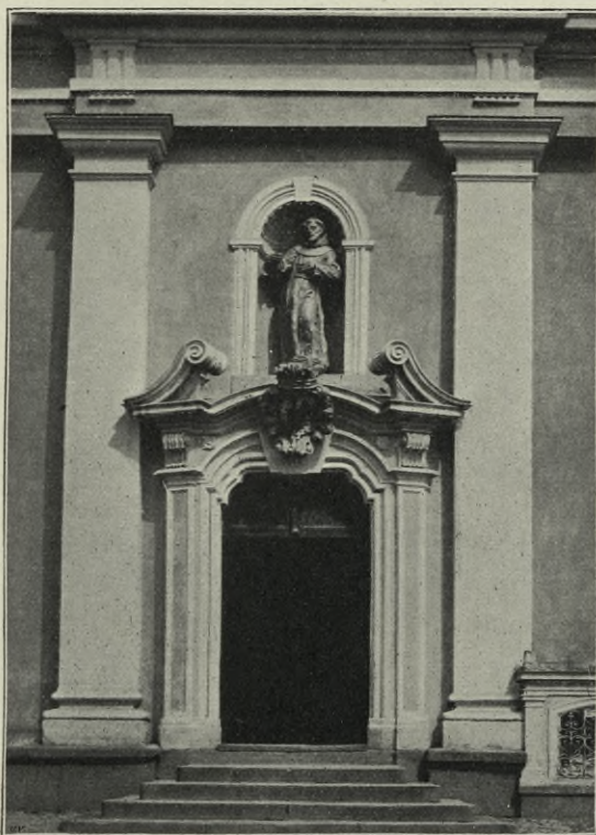
Obr. 256. Turnov. Portál klášterního chrámu sv. Františka.
