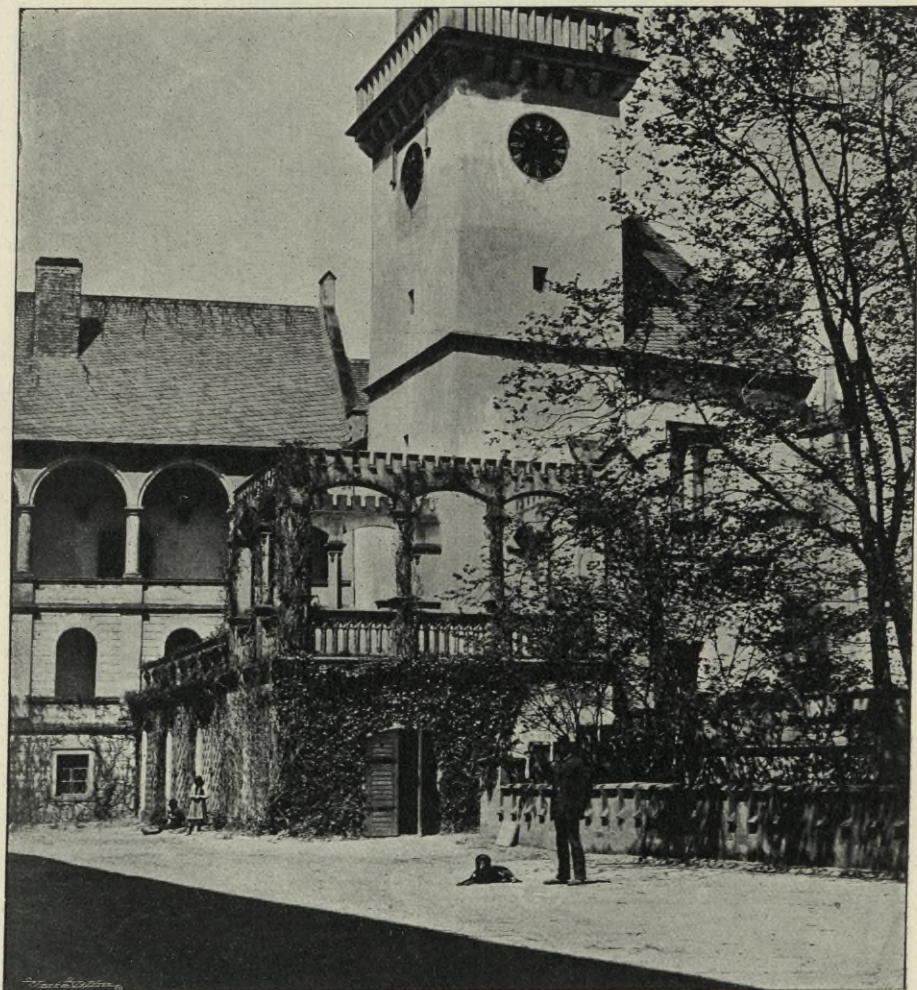
Obr. 170. Hrubá Skála. Severní díl záp. stavení zámekého.
