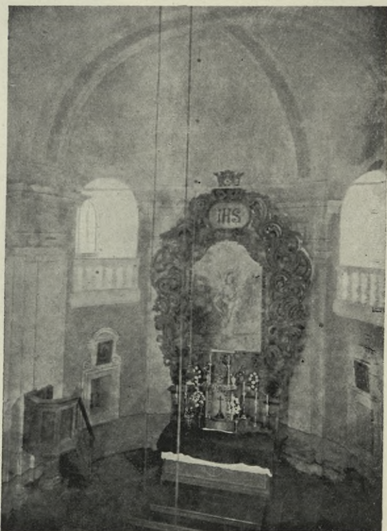
Obr. 49. Jíloví. Vnitřek presbyteria v kapli.
