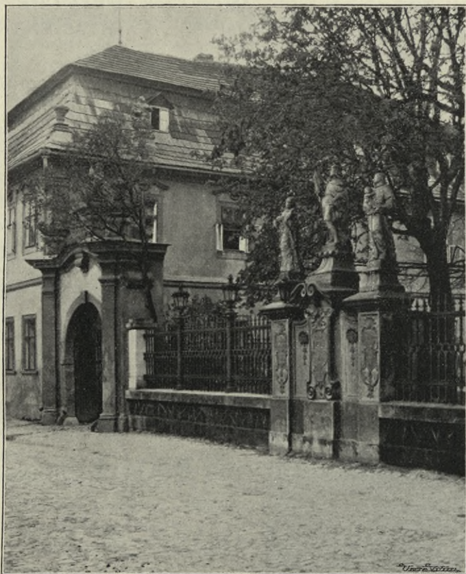
Obr. 263. Turnov. Dům Patočkův, č. 70.
