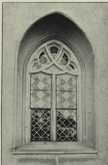
Obr. 97. a 98. Přepěře. Okna.
