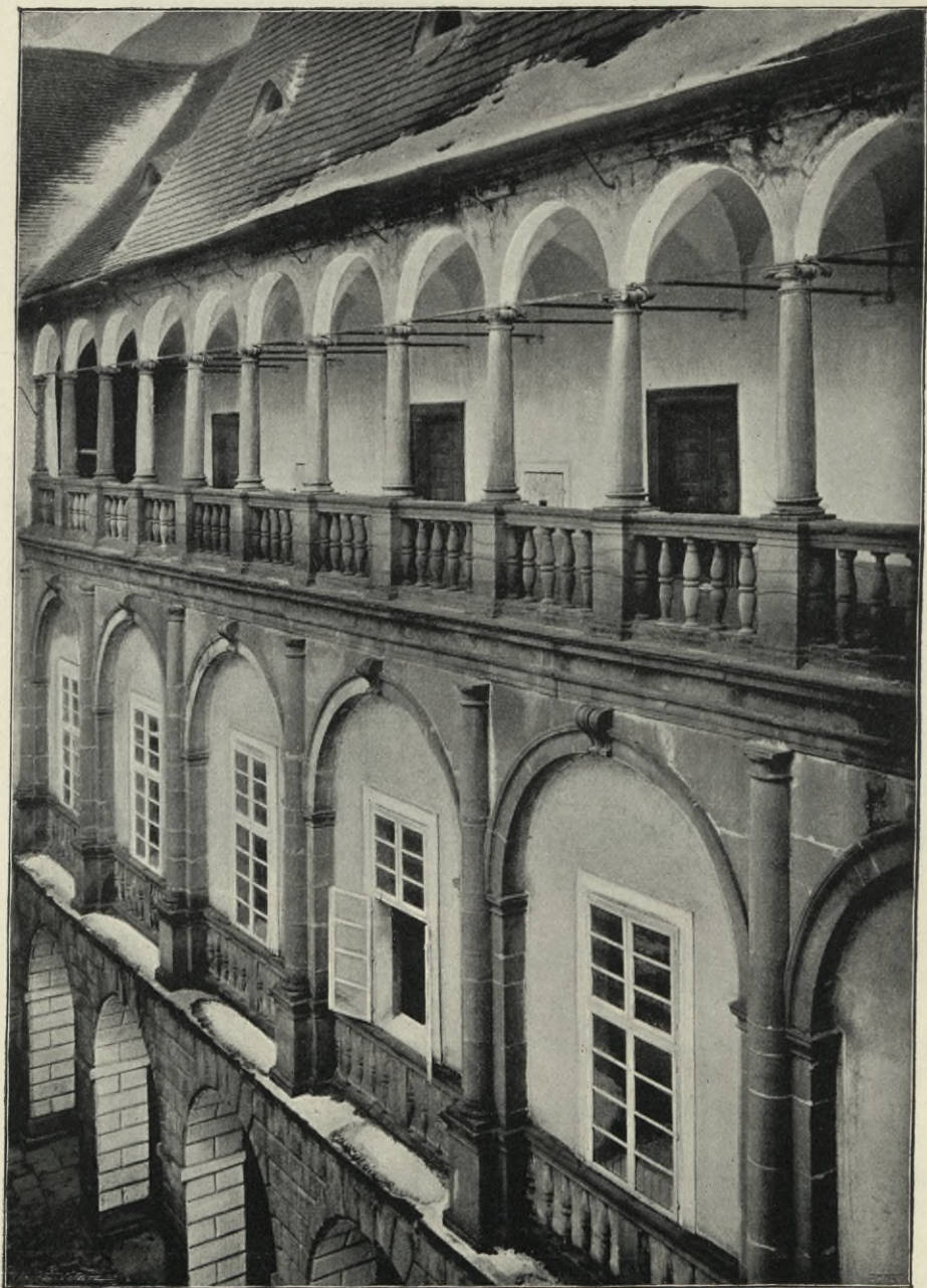
Obr. 105. Kostelec Černý. Zámek. Loggie; pohled se strany.
