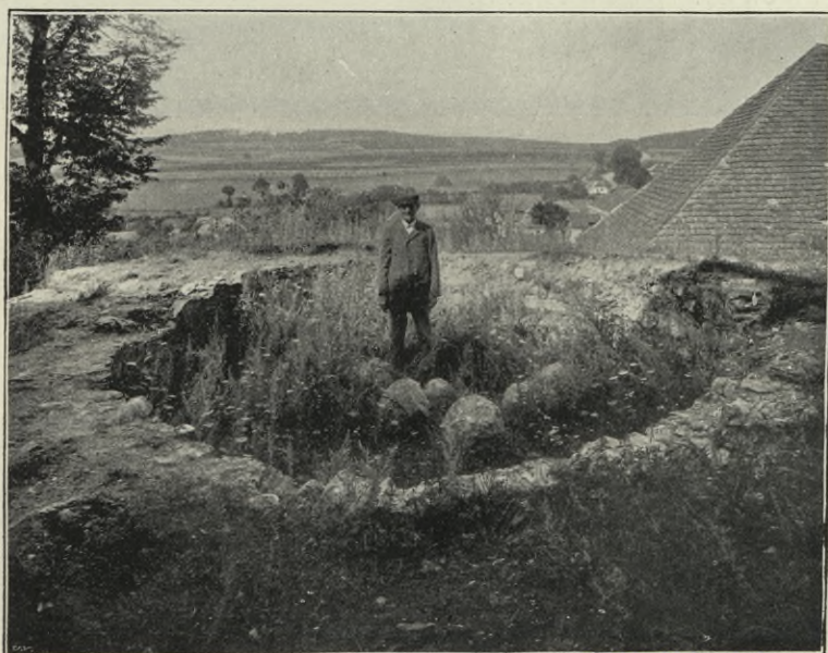
Obr. 247. Skalice. Zbytek hradní bašty.
