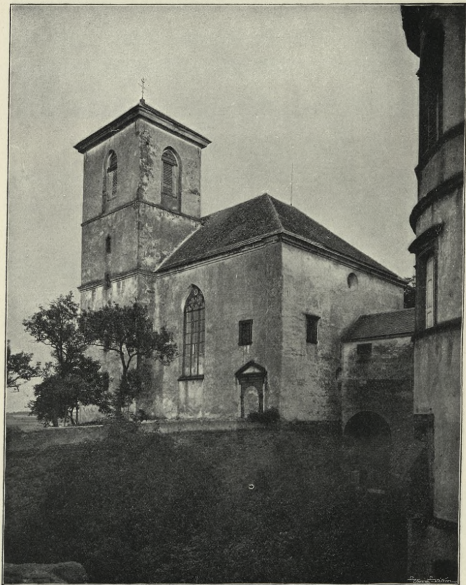
Obr. 112. Kostelec Černý. Zámecký kostel.
