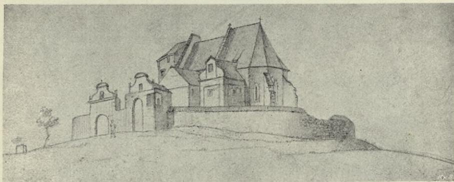
Obr. 212. Radešín. Kostel. Pohled od jihovýchodu. Stav z r. 1865 (s bývalou kaplí sv. Jíří) dle výkresu inž. V. Steinze.
