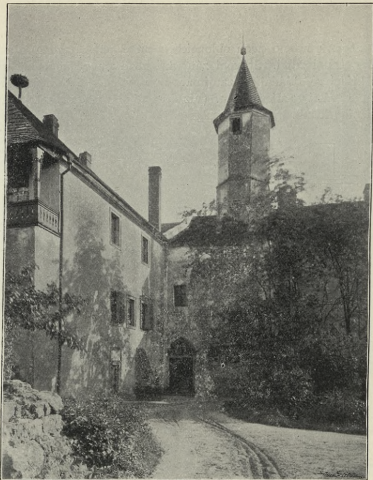
Obr. 183. Prerov n. L. Pohled do nádvoří zámku.
