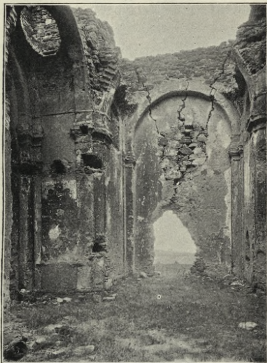
Obr. 65. Bříství. Vnitřek zřícené kaple Povýšení sv. Kříže.
