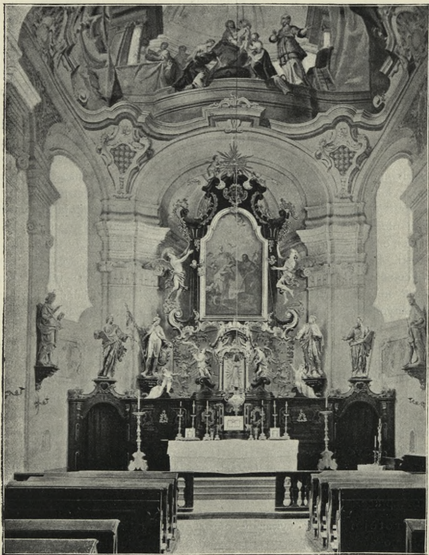
Obr. 283. Vrané. Vnitřek kostela.
