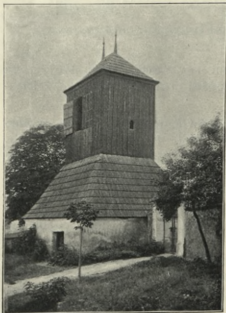
Obr. 25. Hořešovice Velké. Zvonice.
