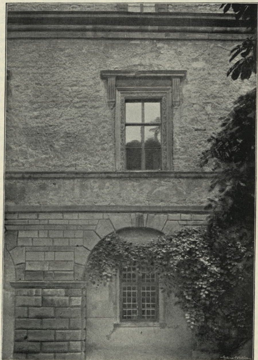
Obr. 114. Nelahozeves. Okno ve východním traktu zámku; zazděná chodba v přízemí.
