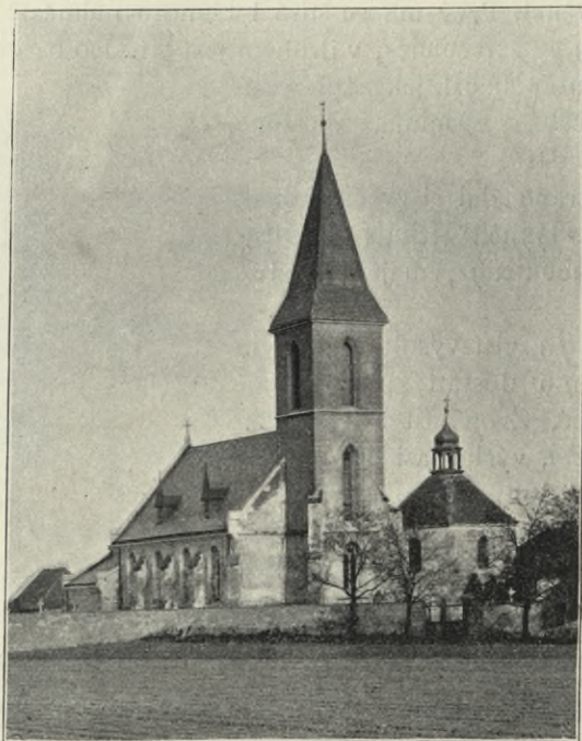
Obr. 137. Velký Páleč. Filiální kostel se zvonici.
