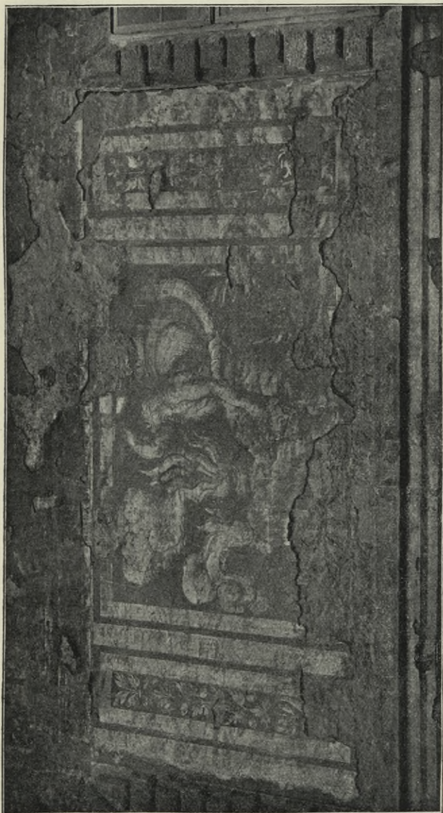
Obr. 307. Nelahozeves. Sgraffita na severní straně zámku.
