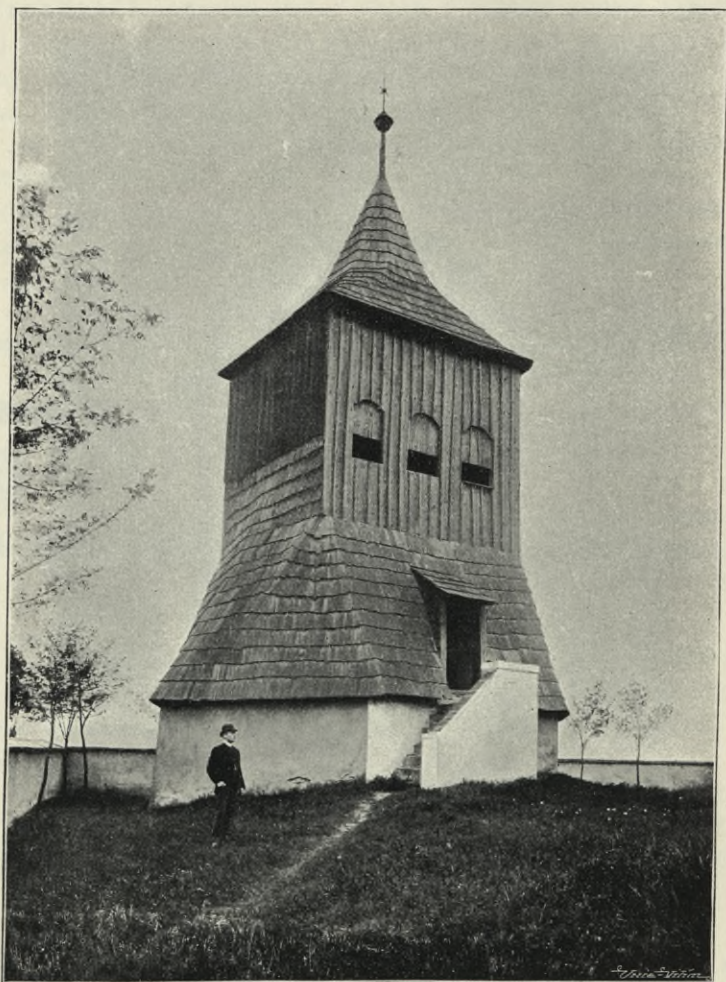
Obr. 155. Přebíslav. Dřevěná zvonice.
