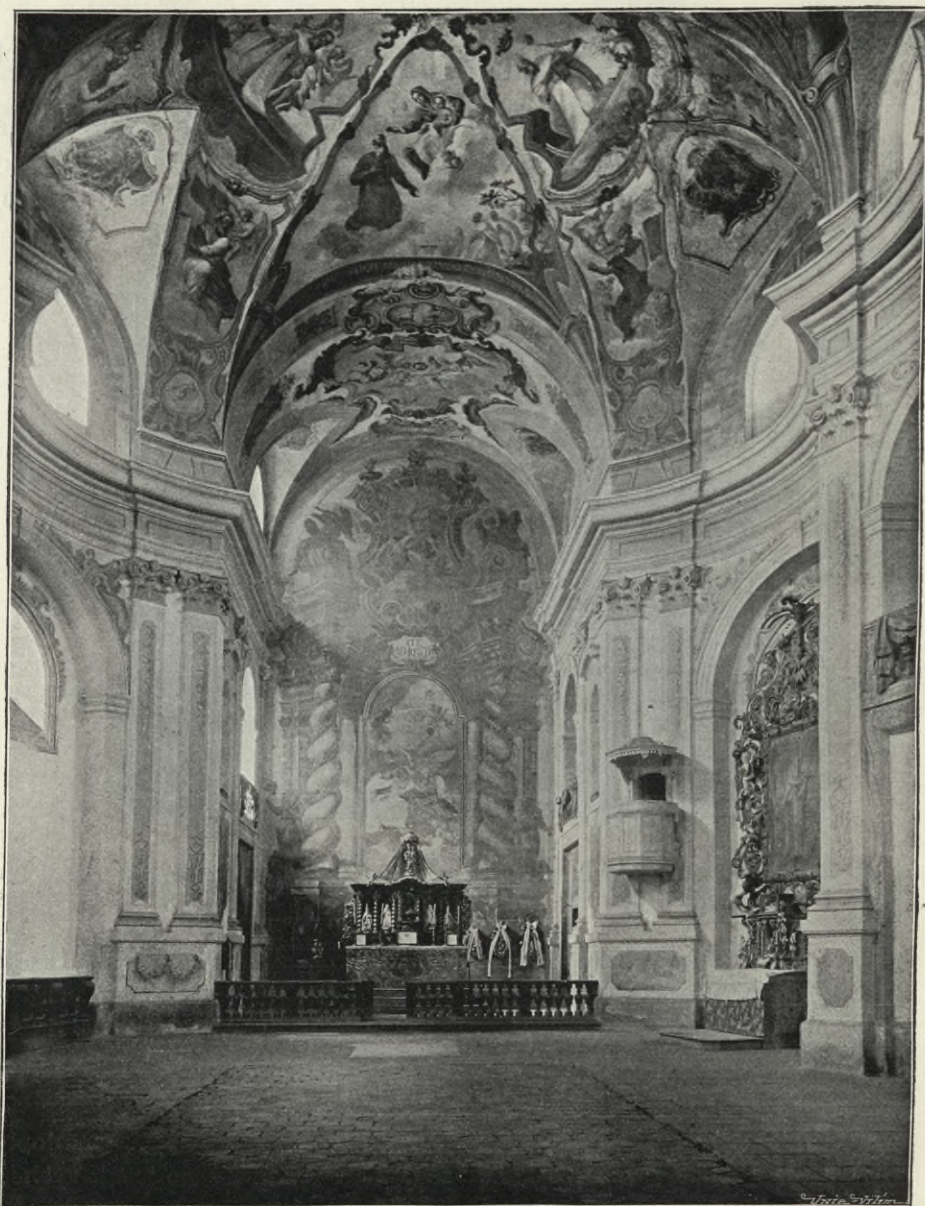
Obr. 92. Obořiště. Vnitřek kostela. (Pohled k oltáři.)
