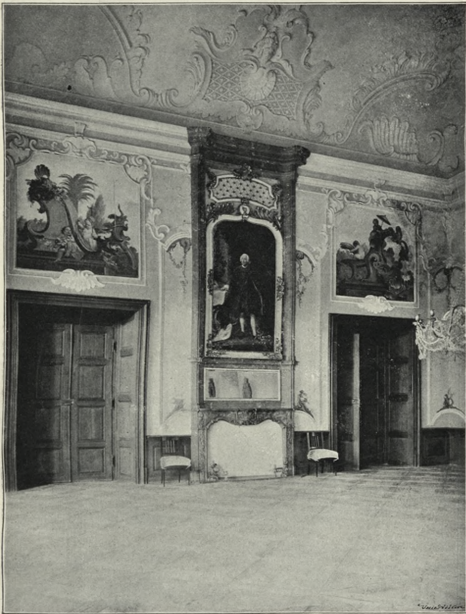
Obr. 19. Dobříš. Východní stěna velikého sálu zámekého.
