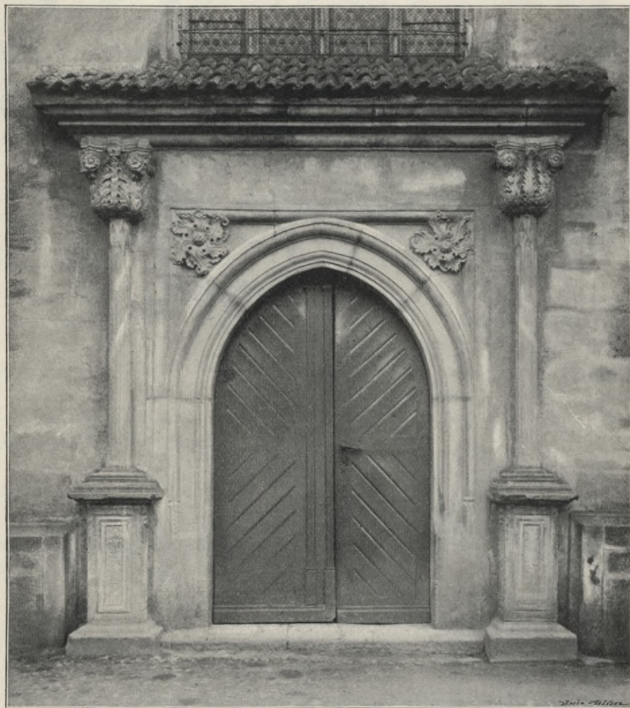
Obr. 60. Chrudim. Kostel sv. Kateřiny; hlavní vchod.
