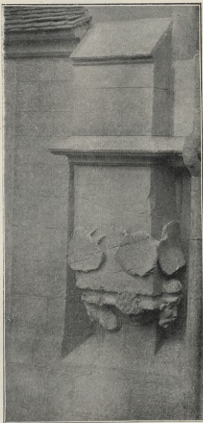
Obr. 30. Chrudim. Fragment opěrného pilíře.
