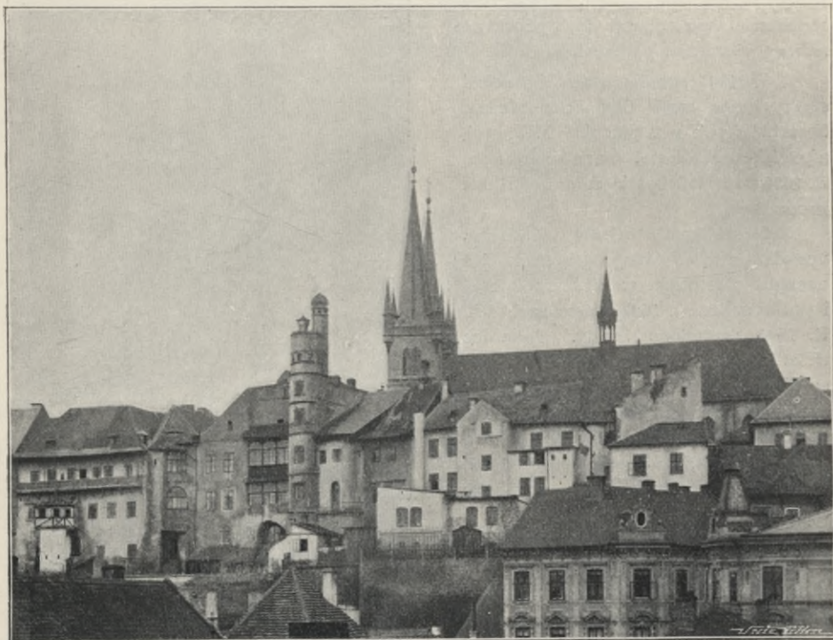
Obr. 29. Chrudim. Pohled od jihu.
