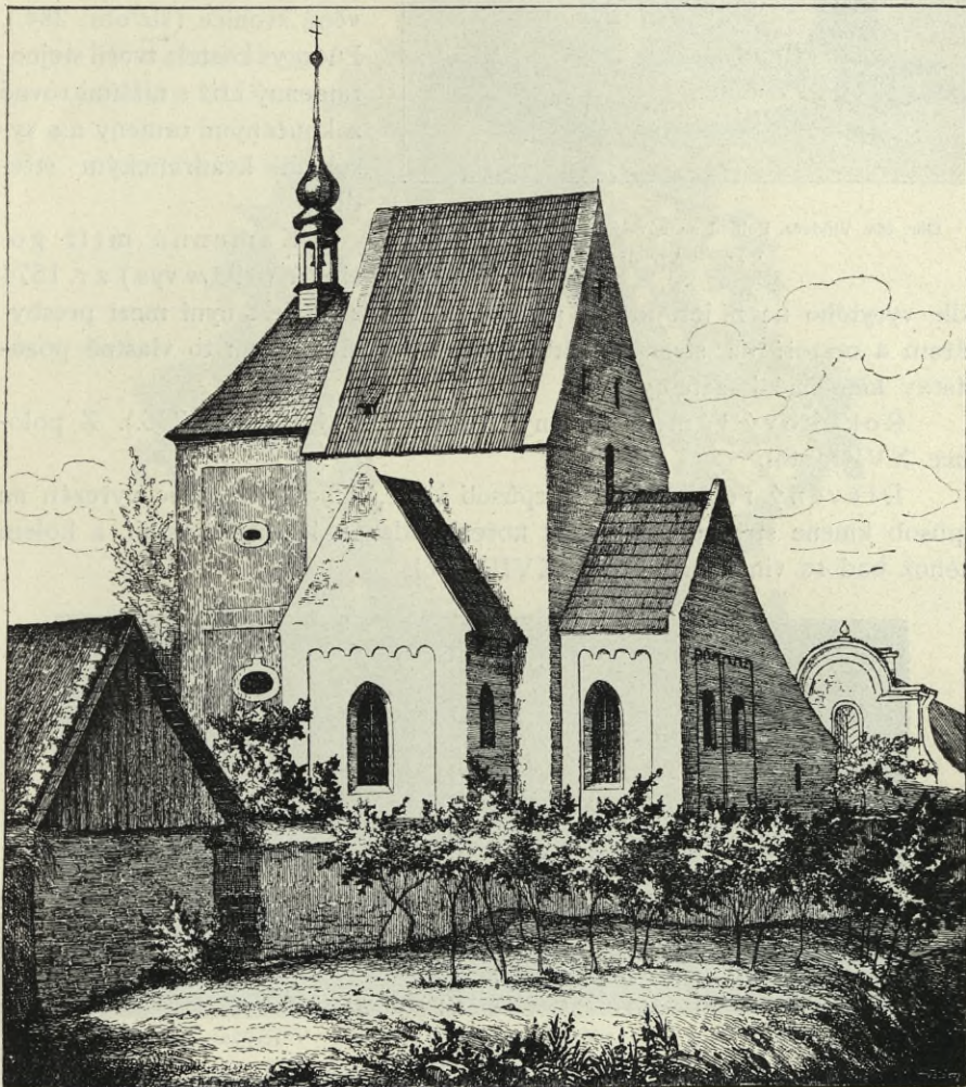
Obr. 283. Vlňoves. Pohled na bývalý kostel dle rytiny Lorenzovy.
