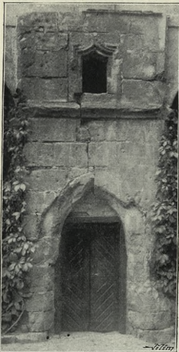
Obr. 204. Mělník, Zámek. Zbytek starého zdíva gotického.
