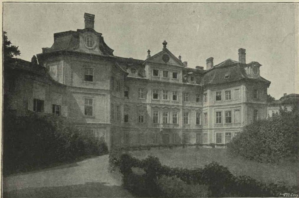
Obr. 26. Hořín. Hlavní průčelí zámku.
