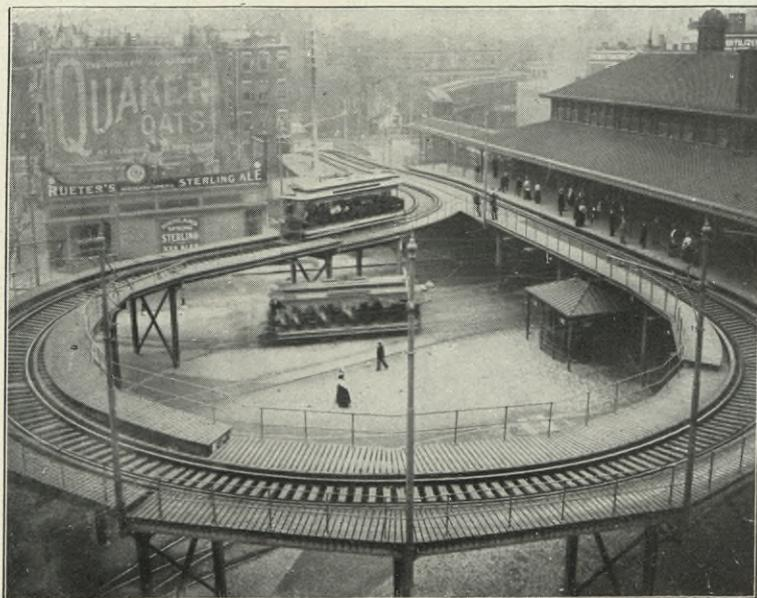
Abb. 273. Straßenbahnschleife mit Umsteigebahnhof für den unmittelbaren Übergang von Trambahn zu Hochbahn ohne Treppenteigen (Dudley-Straße, Boston).
