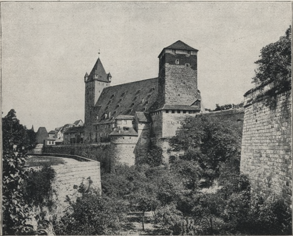
Fünfeckiger Turm, Kaiserstallung und Luginsland. Photographie von Ferdinand Schmidt in Nürnberg.
