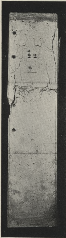
Abb. 19. Säulen 22 bis 24 mit Spiralbewehrung (0,7 cm Durchmesser).
