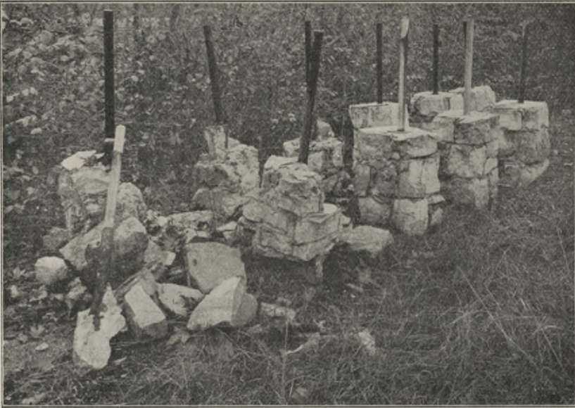
Abb. 10. Verwitterte Mauerwerkskörper aus Kalkstein und Gipsmörtel.
