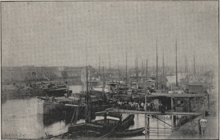
Blick in den hinteren Theil des Kaiserhafens.
