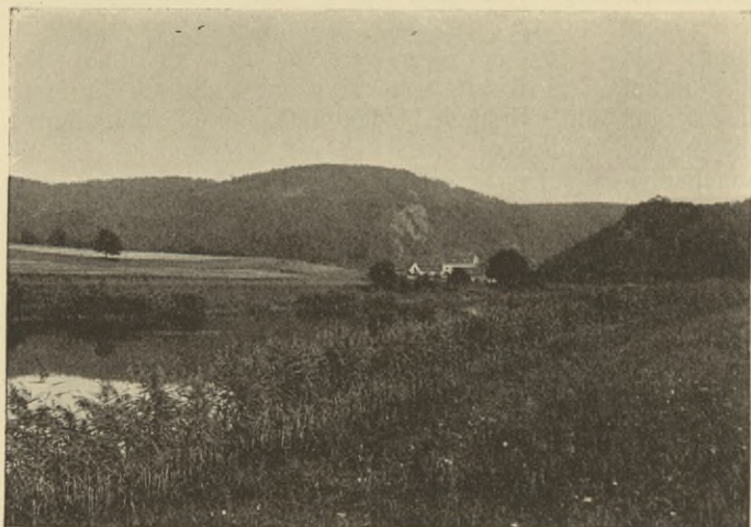
Abb. 10. Ansicht der Baustelle.
