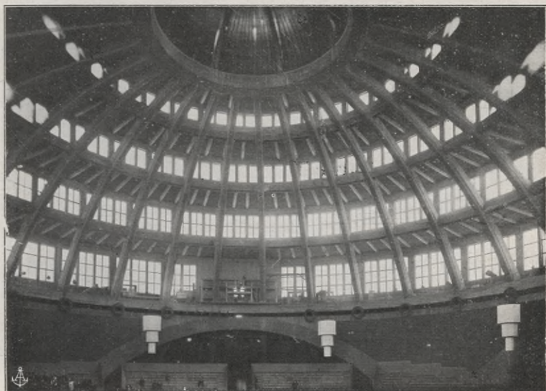
Bild 16. Fernwerk im Bau.
