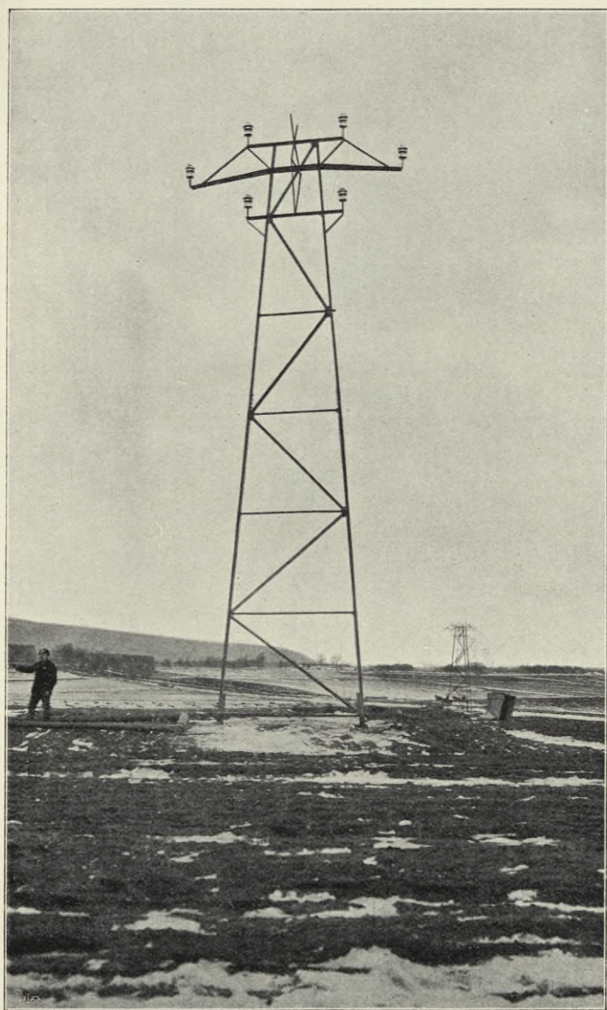
PYLÔNE À DEUX JAMBES DE LA LIGNE TROLLHÄTTAN—SKARA
