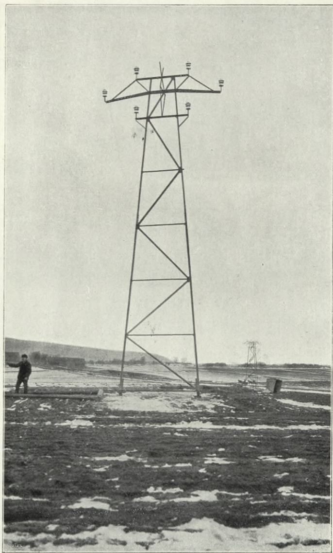
TRAGMAST DER KRAFTLEITUNG TROLLHÄTTAN—SKARA.
