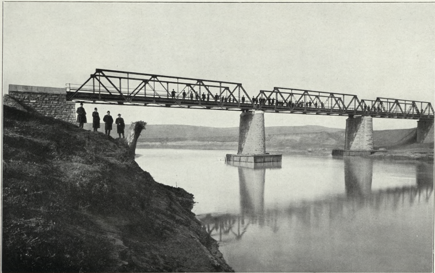
Straßenbrücke über den Jantrafluß bei Trembesch in Bulgarien.
