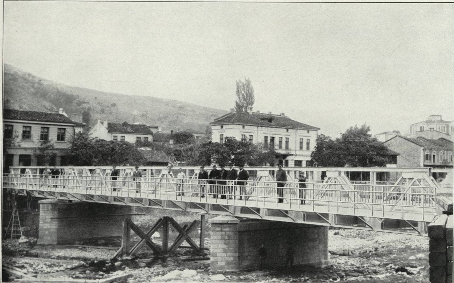
Brücke bei Stanimaka in Bulgarien.
