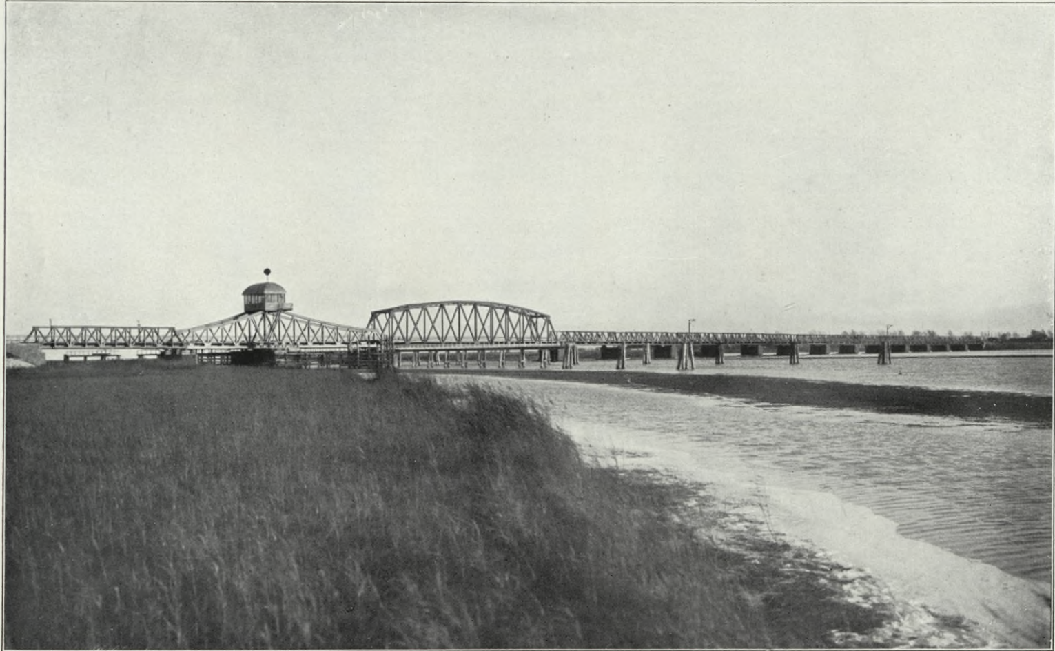
Eiserne Überbauten für die Neubaustrecke Barth-Znigst-Prerow ◦ Brücken über die Meiningen (Ostsee).
