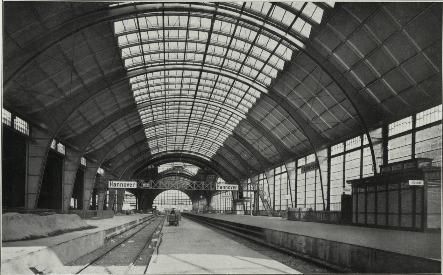
Erweiterungsbau des Hauptbahnhofes Hannover am Raschplatz.
