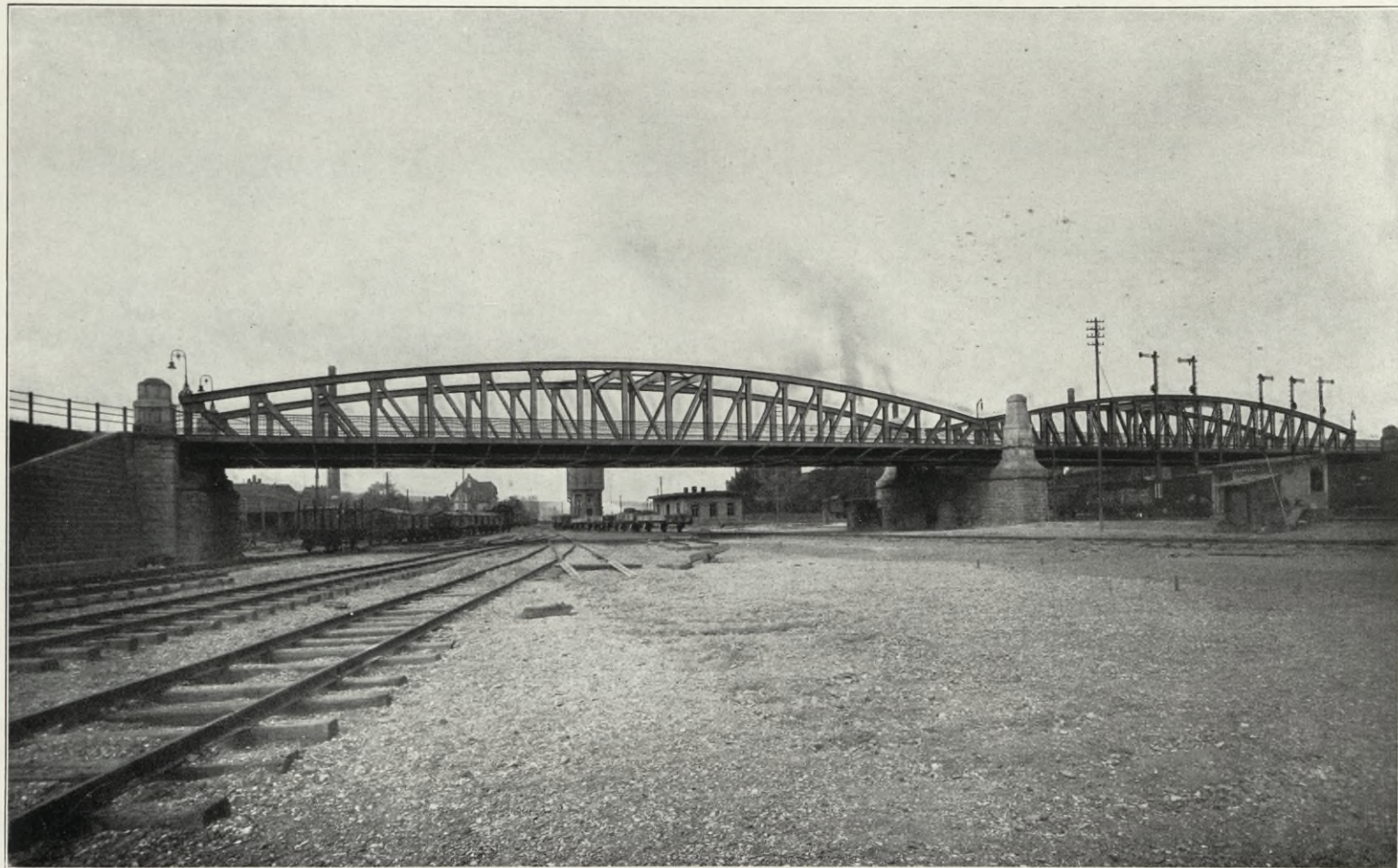
Unterführung des Römerrings in Hildesheim.
