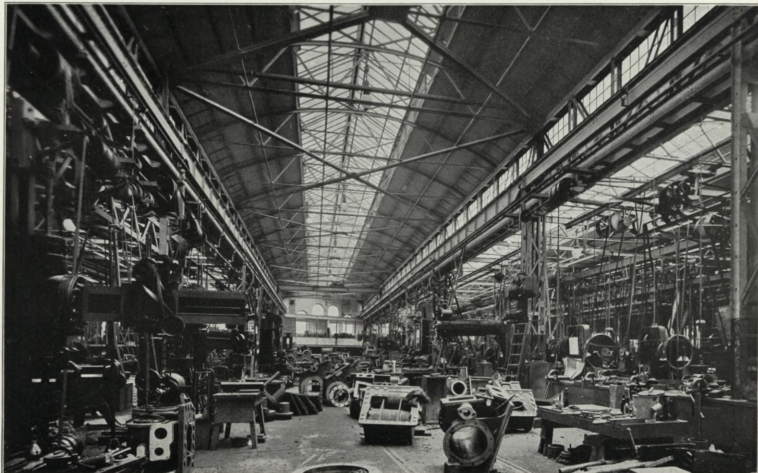
Hannoversche Maschinenbau-A.G. vormals Georg Egestorff in Linden • Drehereigebäude.
