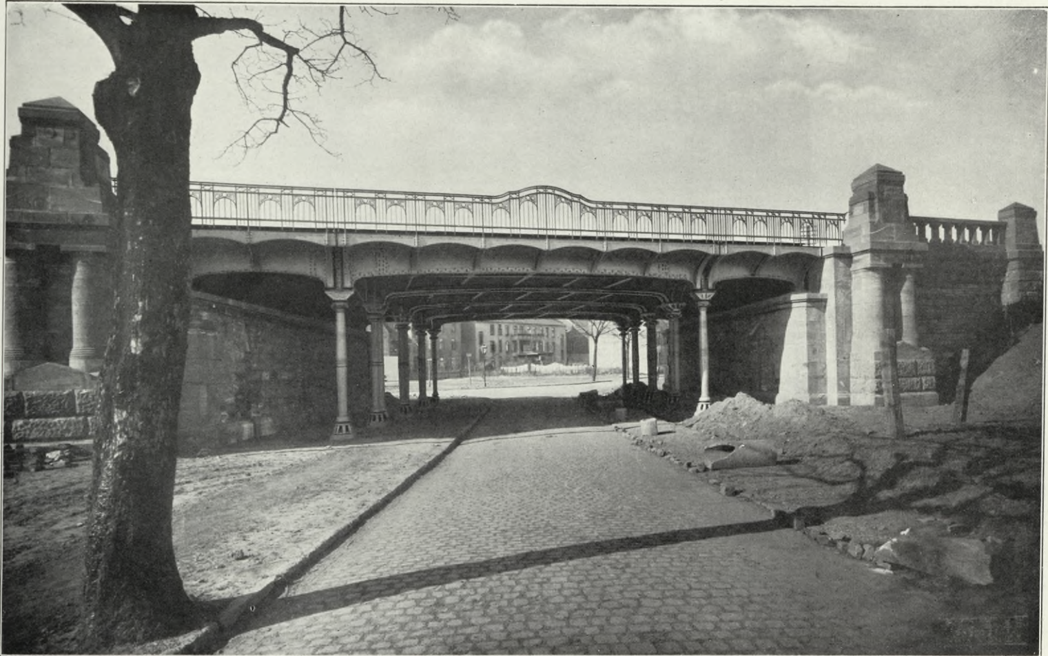
Überbauten für die Umgebungsbahn Wunstorf-Lehrte ◦ Unterführung der Landwehrstraße in Hannover.
