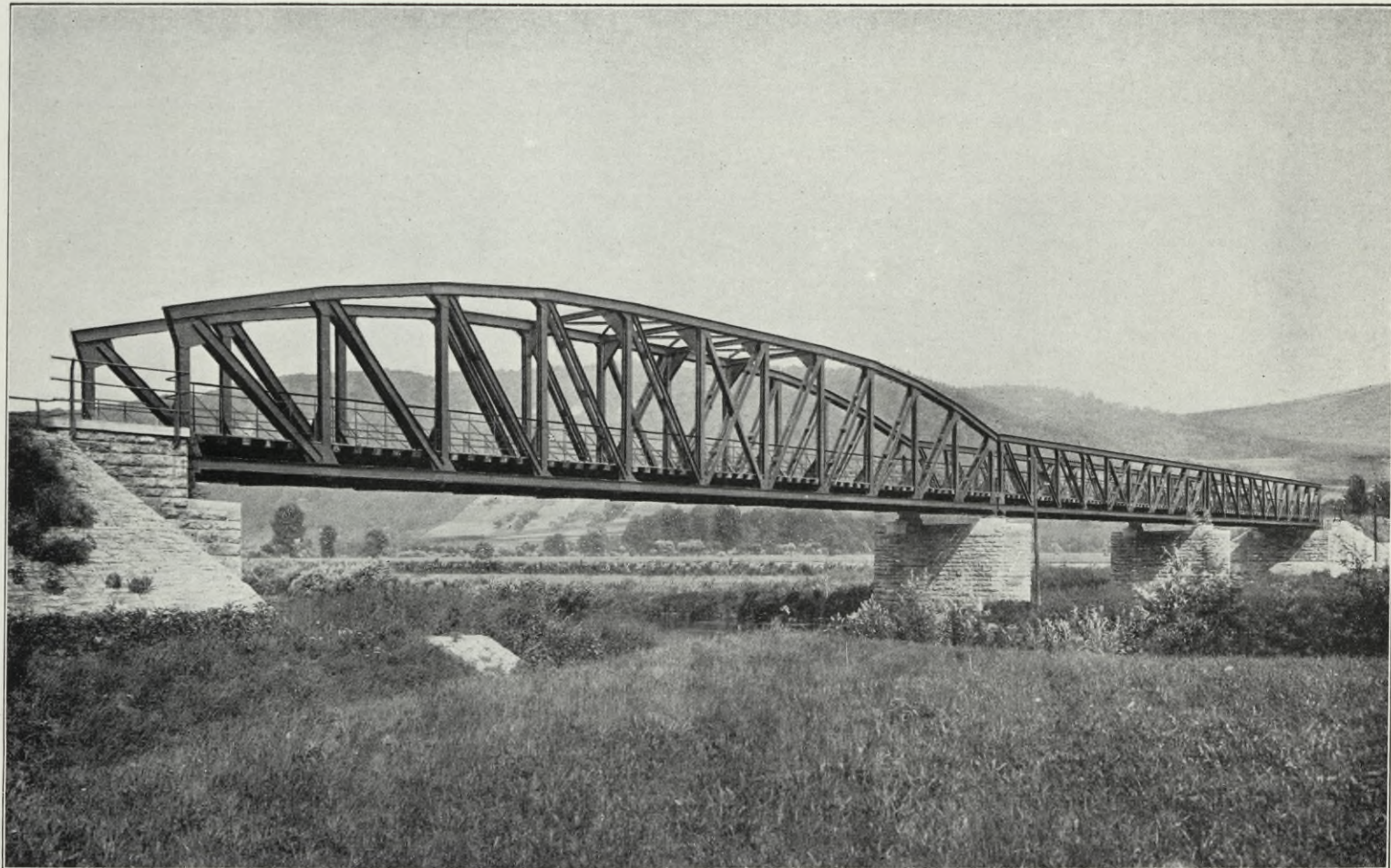
Überbauten für die Neubaustrecke Eisenberg-Bürgel-Porstendorf (Saalestrombrücke).
