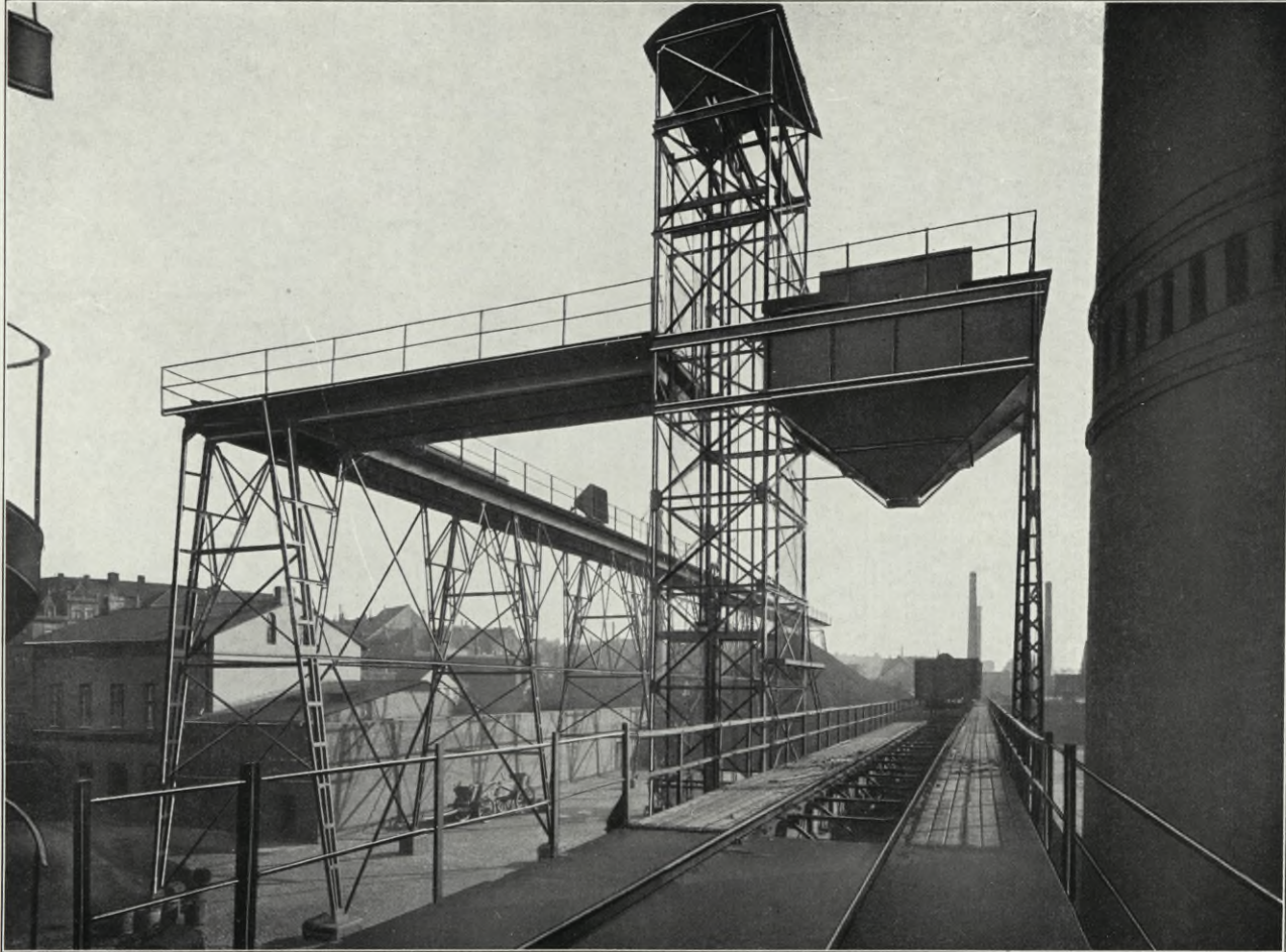
Koksverladebrücke und Aufzug für die Gasanstalt in Hannover.
