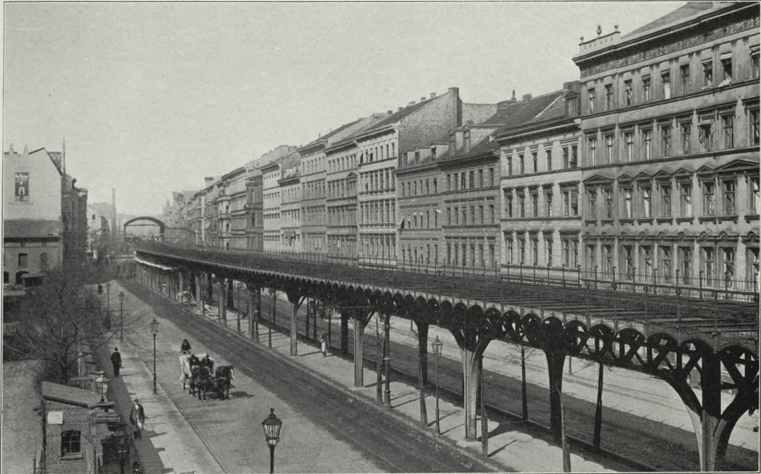
Eisenkonstruktion für die Berliner Hochbahn in der Gitschinerstraße von km 47,5 bis km 55,46.
