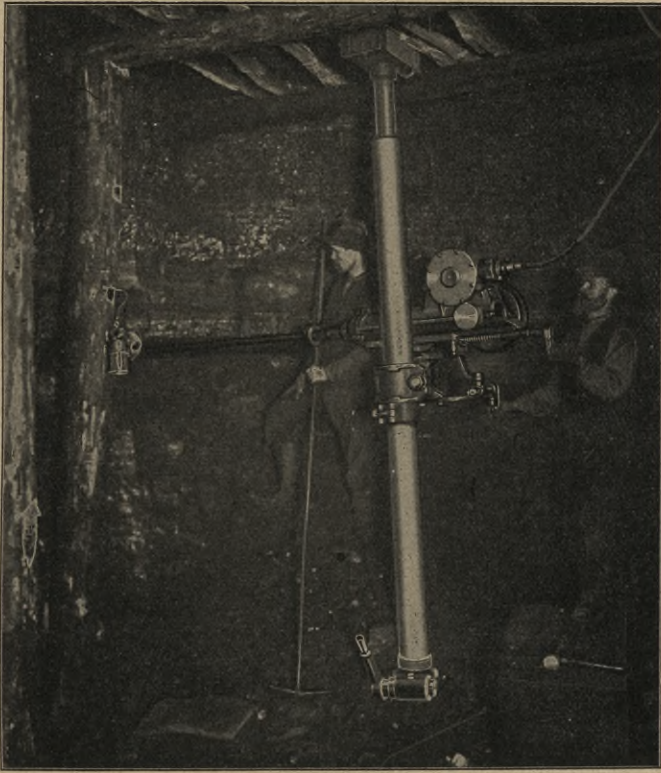
Motor-Bohrmaschine als Schrämmaschine benutzt. (Siemens.)
