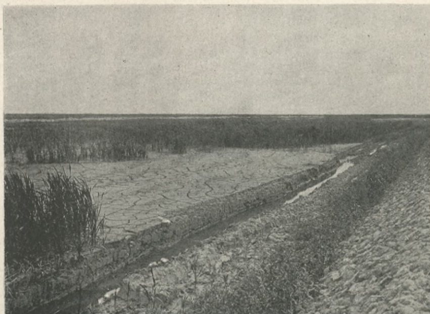
Fig. 33. — Kolmationsanlagen von Ravenna. Vollendete Kolmation mit dem Umfassungsdamm.
