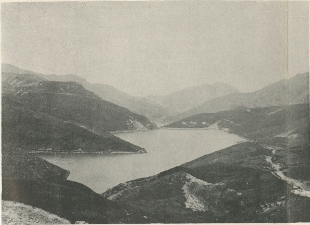
Fig. 19. — Acquedotto de Ferrari Galliera. Blick auf die Talsperren Lago Lungo (im Vordergrund) und Lago Lavezze (im Hintergrunde) am Gorzente.
