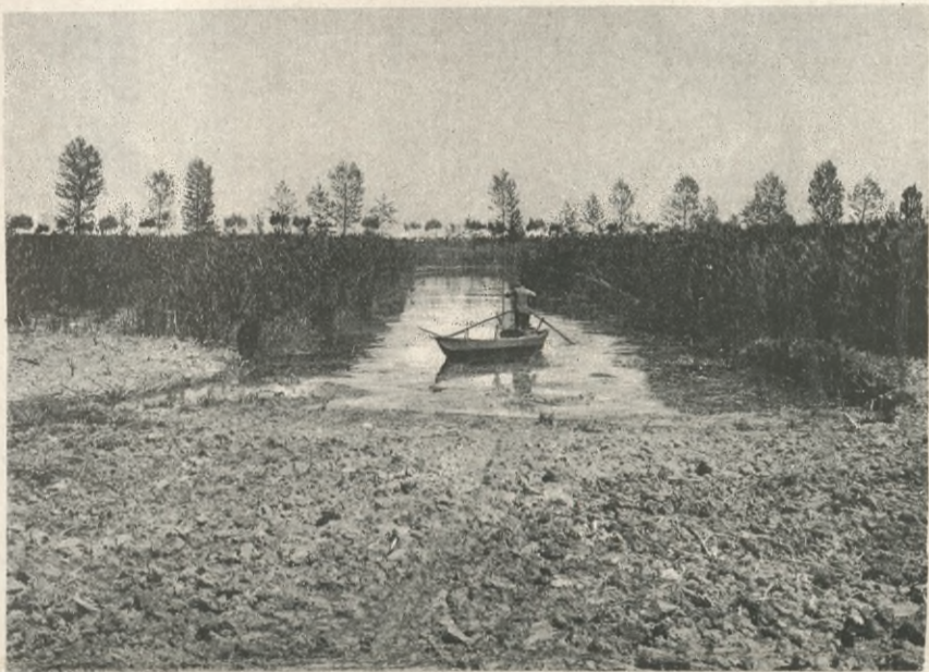
Fig. 3. — Entwässertes Gelände des Gutes Fiumicino.
