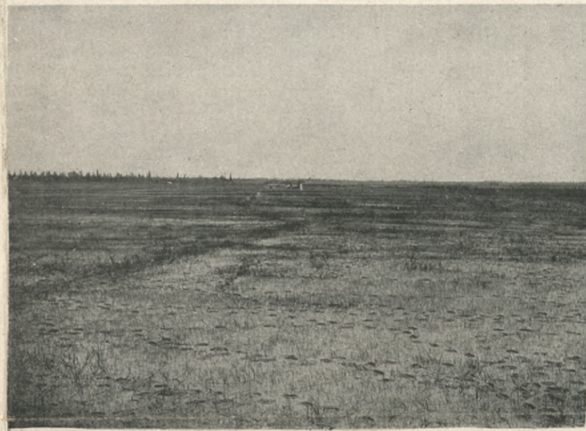
Fig. 36. — Entwässerungskanal von Zaniola nach dem Meere. Vollendete Strecke.
