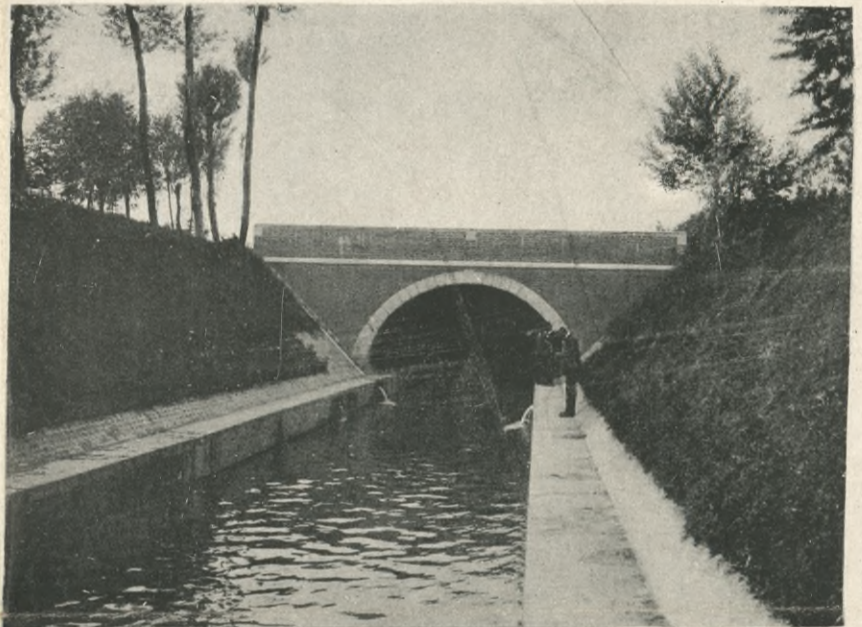
Fig. 7. — Hauptsammelkanal «Gentilino» (Entwässerung von Mailand). Offene Kanalstrecke mit Böschungsversicherung.
