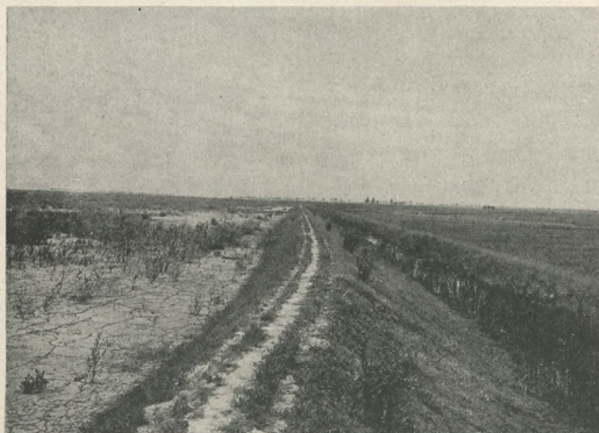
Fig. 33. — Kolmationsanlagen von Ravenna. Vollendete Kolmation mit dem Umfassungsdamm.
