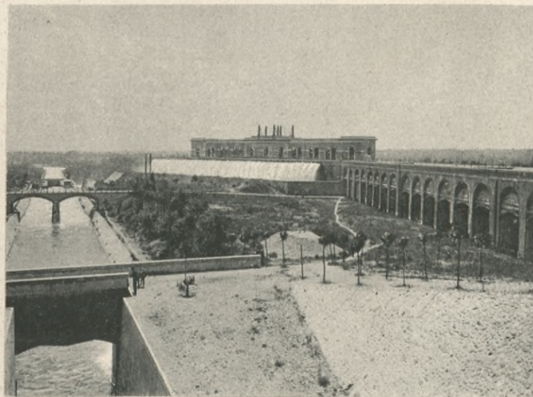
Fig. 17. — Turbinenanlage und Elektrizitätswerk am Industriekanal von Vizzola-Ticino.
