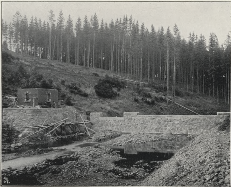
Vor- und Wehrtichmauer im Bau.
