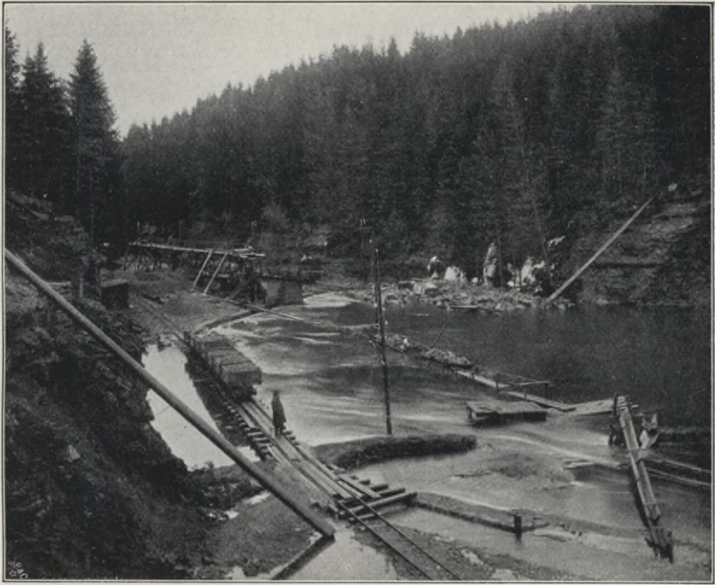
Sperrmauer, Baugrube unter Wasser.
