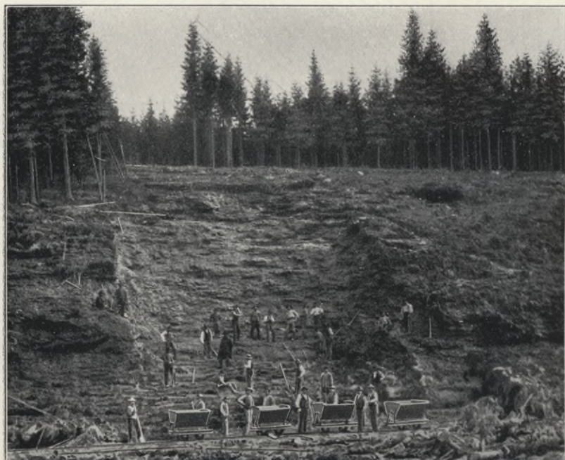
Sperrmauer, rechtsseitiges Widerlager.
