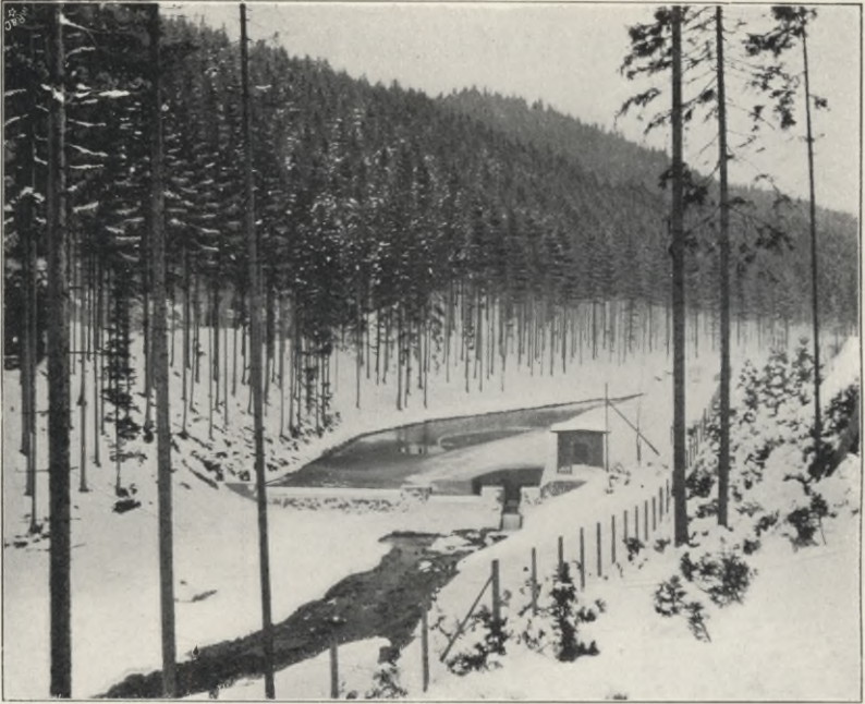
Teich gefüllt und im Betrieb.
