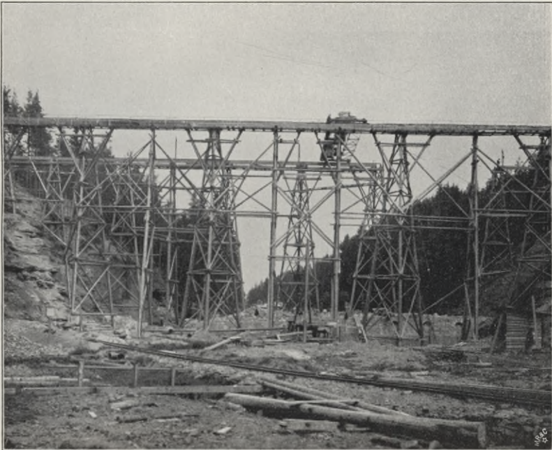
Sperrmauer, Kranengerüst in zweiter Stellung.
