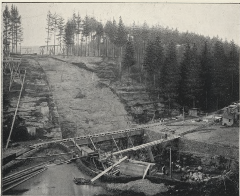
Sperrmauer, linksseitiges Widerlager.
