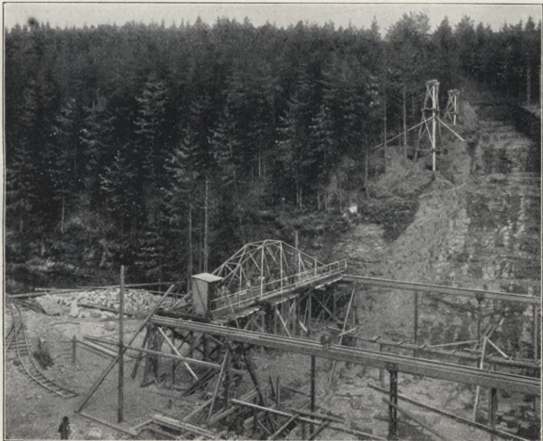
Sperrmauer, Krangerüst in erster Stellung.
