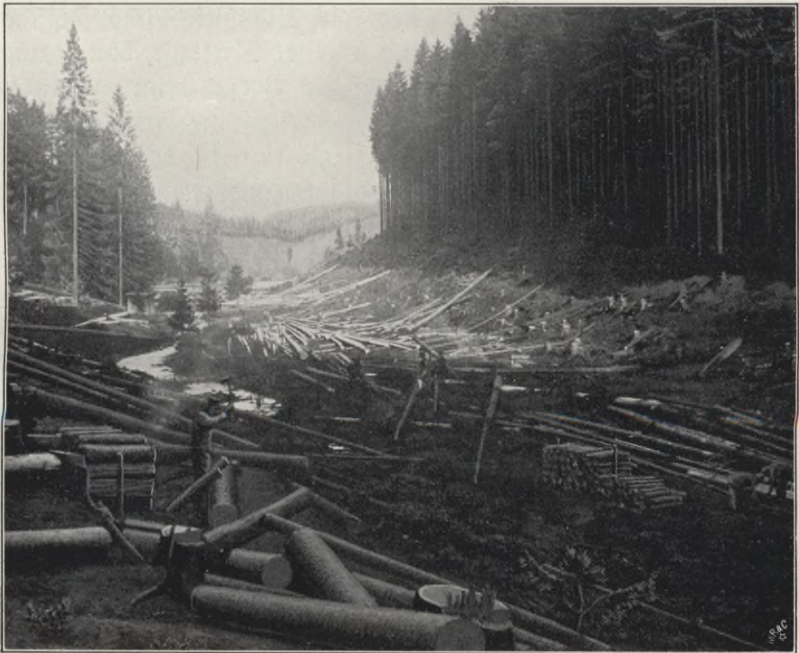
Blick in den Mittelwassergrund. (Anfang der Arbeit).
