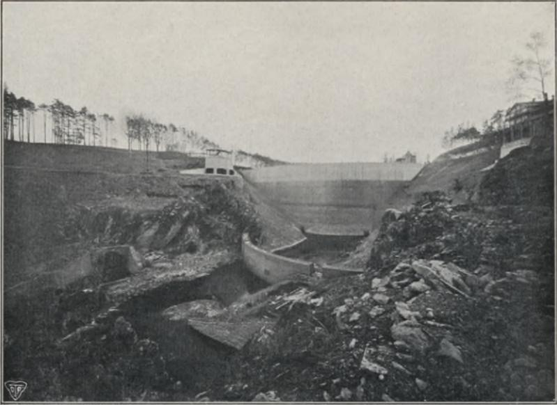
Abb. 27 a. Wasserseite der Talsperre. Im Vordergrund links der Einlauf des linken Umlaufstollens gegenüber dem Einlauf des rechten Umlaufstollens. In der Mitte das Betonwehr zur Umleitung des Queis, dahinter die grosse Sperrmauer. Oben links und rechts die Entlastungsanlagen.
