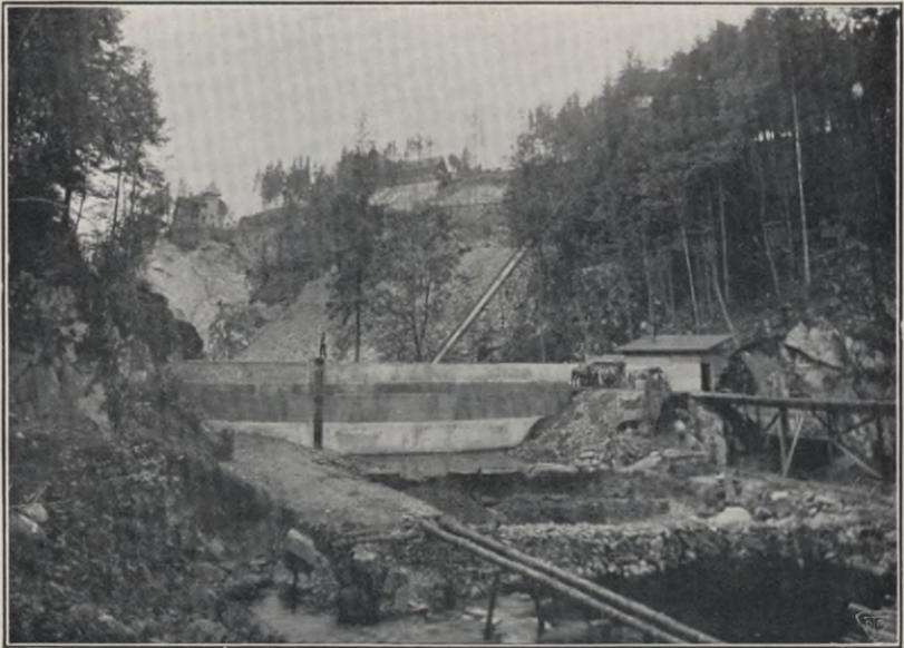
Abb. 18. Fertiges Betonwehr zur Umleitung des Queis durch die Umlaufstollen von der Wasserseite.
