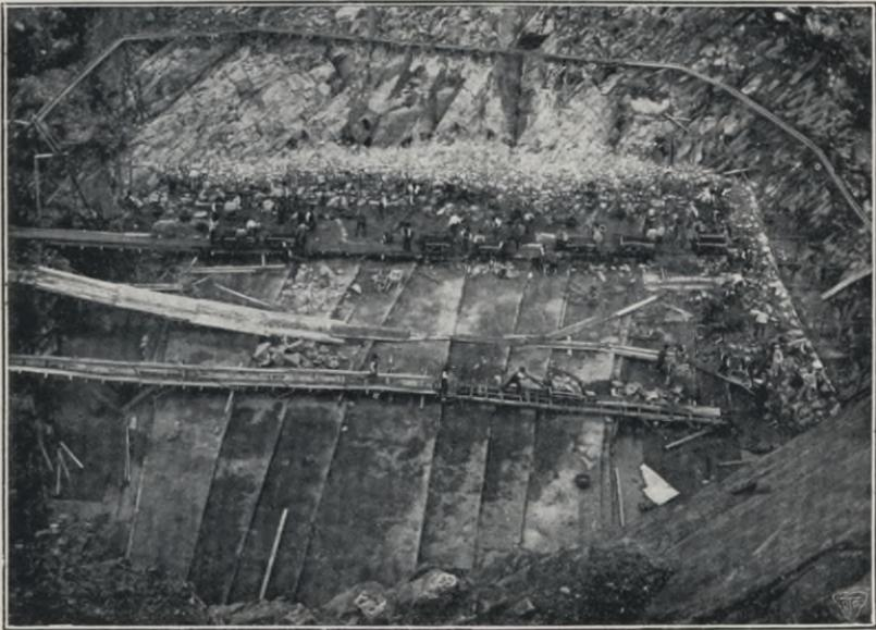
Abb. 21. (Von der Höhe gesehen.) Beginn mit der Aufmauerung der Sperrmauer in Bruchstein-Mauerwerk nach Fertigstellung der Betonsohle am 17. September 1902.
