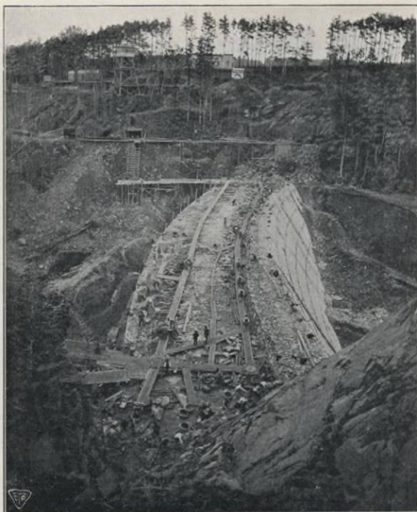
Abb. 23. Aufmauerung der Sperrmauer von oben gesehen.
