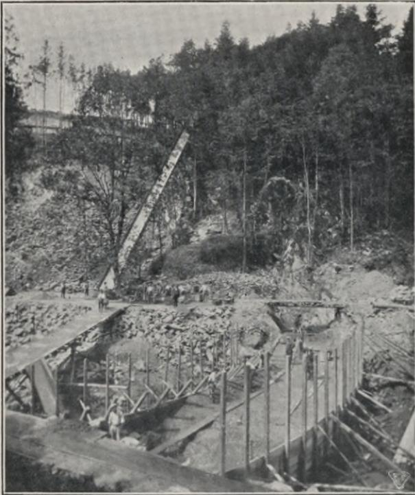
*Abb. 17. Bau des Betondammes zur Abdämmung des Queis vor der Baustelle der Sperrmauer behufs Umleitung des Queiswassers durch die Umlaufstollen. Auf der Rutschbahn wird der Betonsand zur Mischbühne gefördert, hier gemischt und dann in Lagen zwischen das Gerüst, welches durch Bretter verschalt ist, gestampft.*
