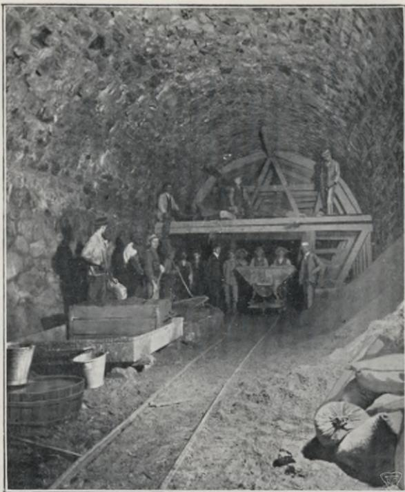
Abb. 15. Fertig in Bruchsteinmauerwerk ausgemauertem Umlaufstollen.
