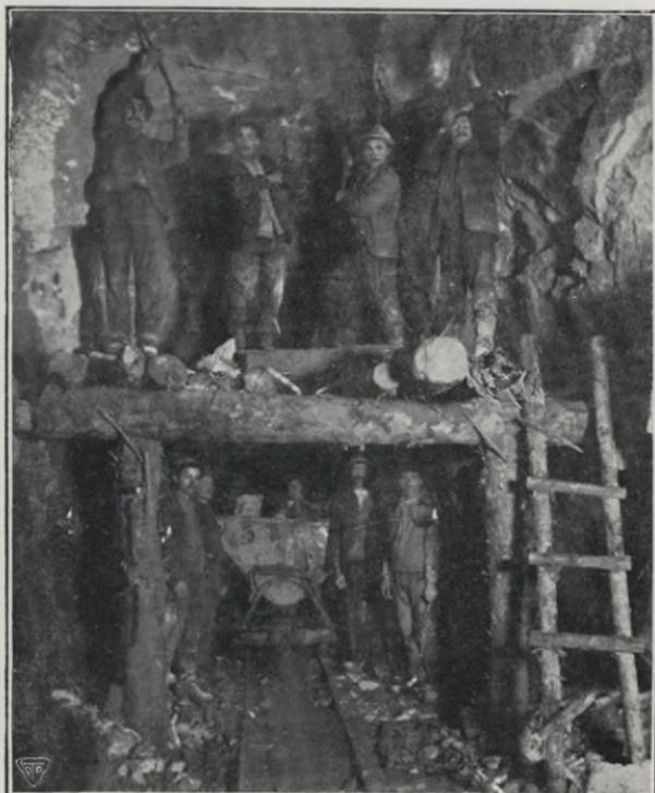
Abb. 14. Durchbruch der Umlaufstollen zur Umleitung des Queis während der Bauzeit. Nachdem der untere Sohlstollen bereits weiter vorgetrieben, wird oben vom Gerüst aus der Firststollen abgebrochen.
