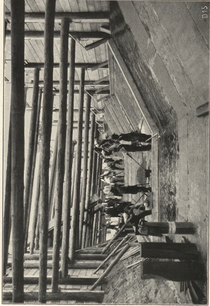
Betonierung der Ringsohle des Bassins.
