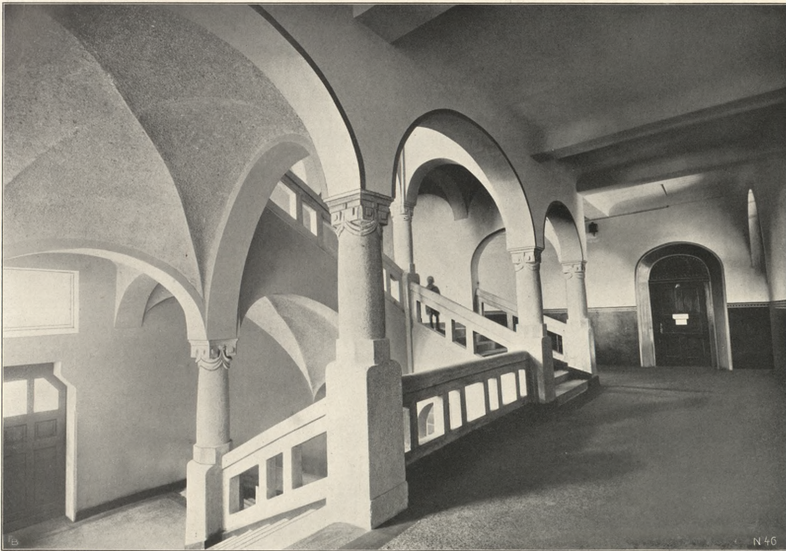
Treppenhaus-Anlage in der Nordschule in Jena mit Eisenbeton-Kreuzgewölben. 1907.
