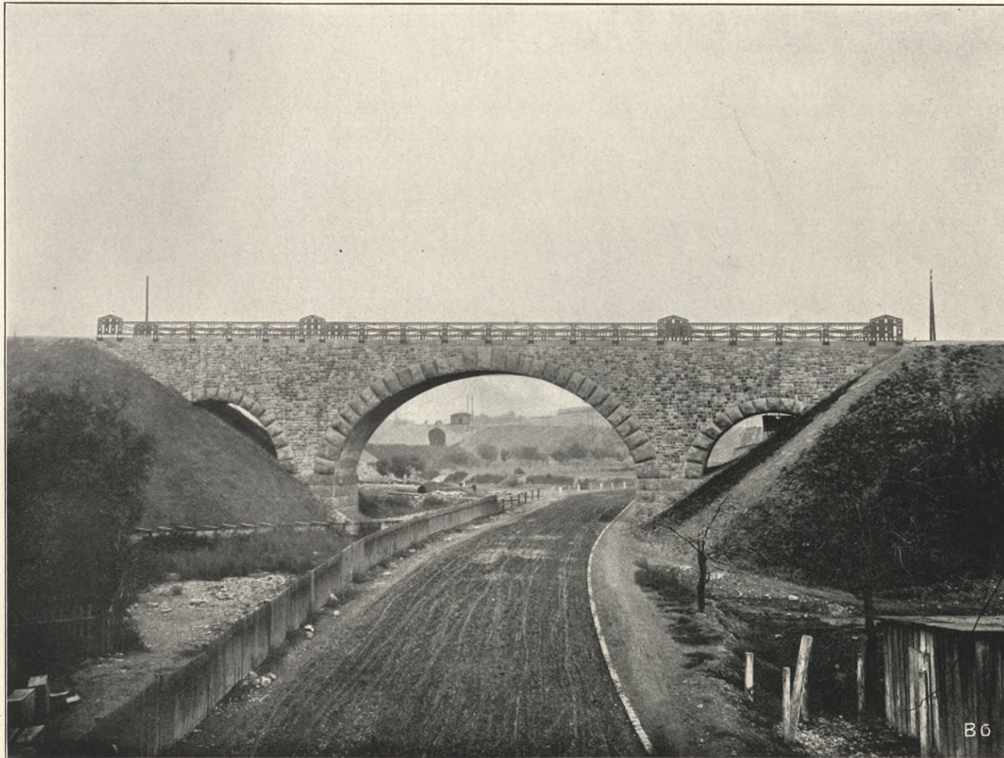
Unterführung der Weststraße unter der Güterlinie Biebrich Ost-Wiesbaden. Drei Bögen von 4,50 m Breite, 20,00 bis 8,50 m Spannweite und 7,00 bis 4,25 m Pfeilhöhe. 1905.
