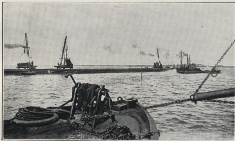
Der Königsberger Seekanal: Bau der Kanaldämme.
