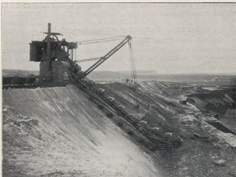
Eimerketten-Trockenbagger.
