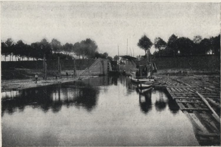
Die Hafenschleuse in Brahemünde.
