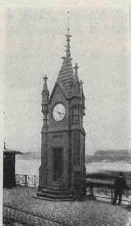
Pegelhäuschen in Cöln a. Rhein.
