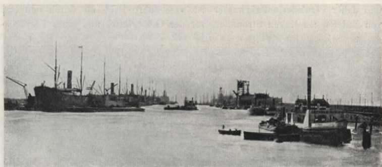
Der Außenhafen in Emden.
