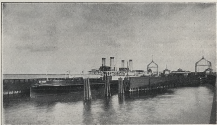
Ansicht der Anlegestelle von der Seeseite.
