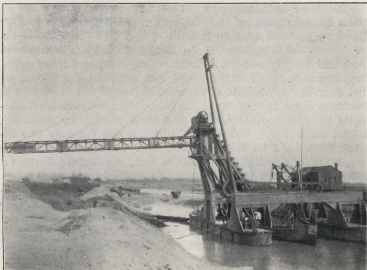
Elevator zum Entleeren von Baggerprähmen.
