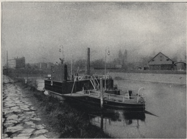
Taucherschacht der Elbstrombauverwaltung.
