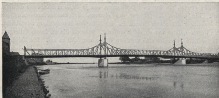
Die Oderbrücke bei Ohlau.
