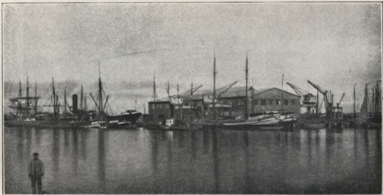
Der neue Binnenhafen in Emden.
