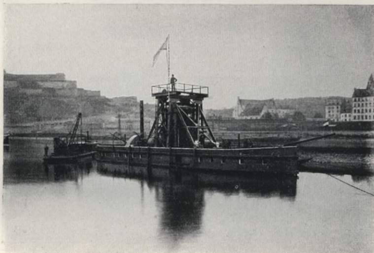
Taucherschacht der Rheinstrombauverwaltung.
