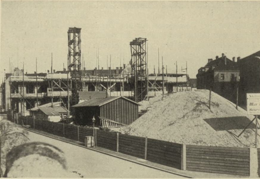
Abb. 12. Stand der Bauarbeiten am 6. Mai 1915.
