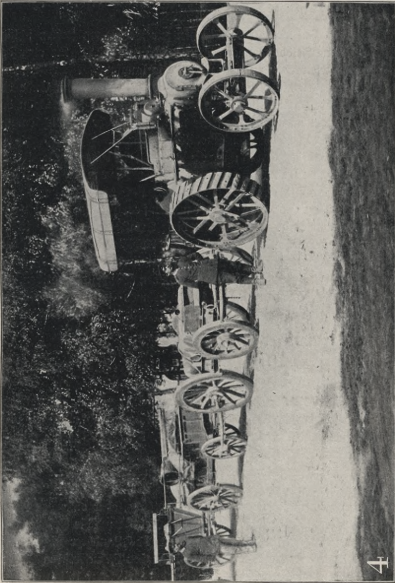
Abbild. 26. Militär-Straßenlokomotive, Type Malta, von John Fowler & Co. in Magdeburg, mit Trestmagennug.
