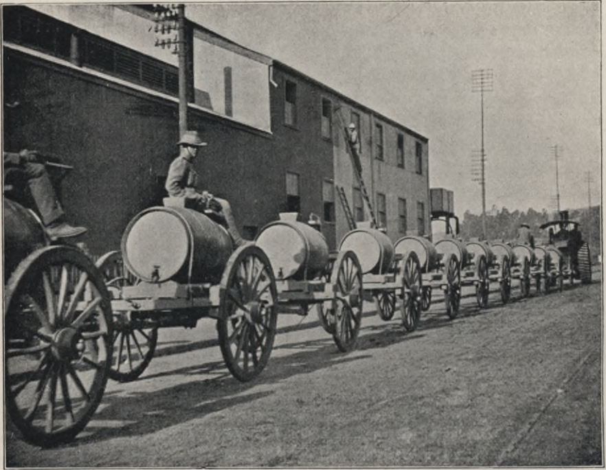
Abbild. 9. Verwendung der Fowlerschen Straßenlokomotive zur Wasserzufuhr.
