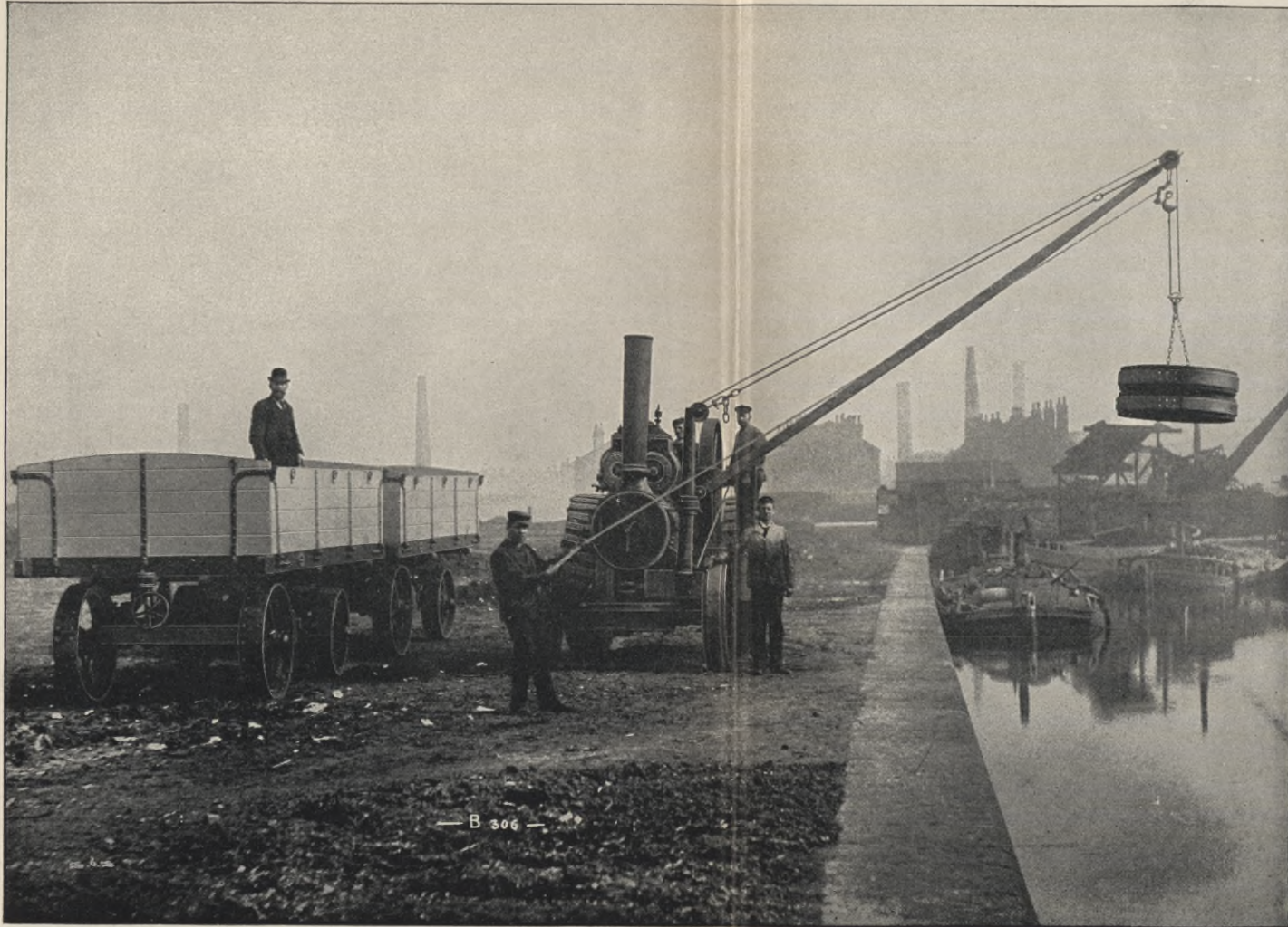
Verwendung der Fowler'schen Straßenlokomotive in Verbindung mit leichtem Krahn.
