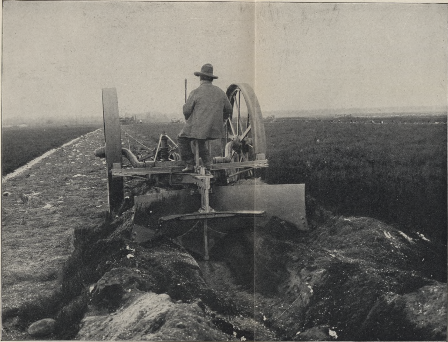
Fowlers Dampfplug zum Gräbenziehen bis 75 Zentimeter Tiefe.
