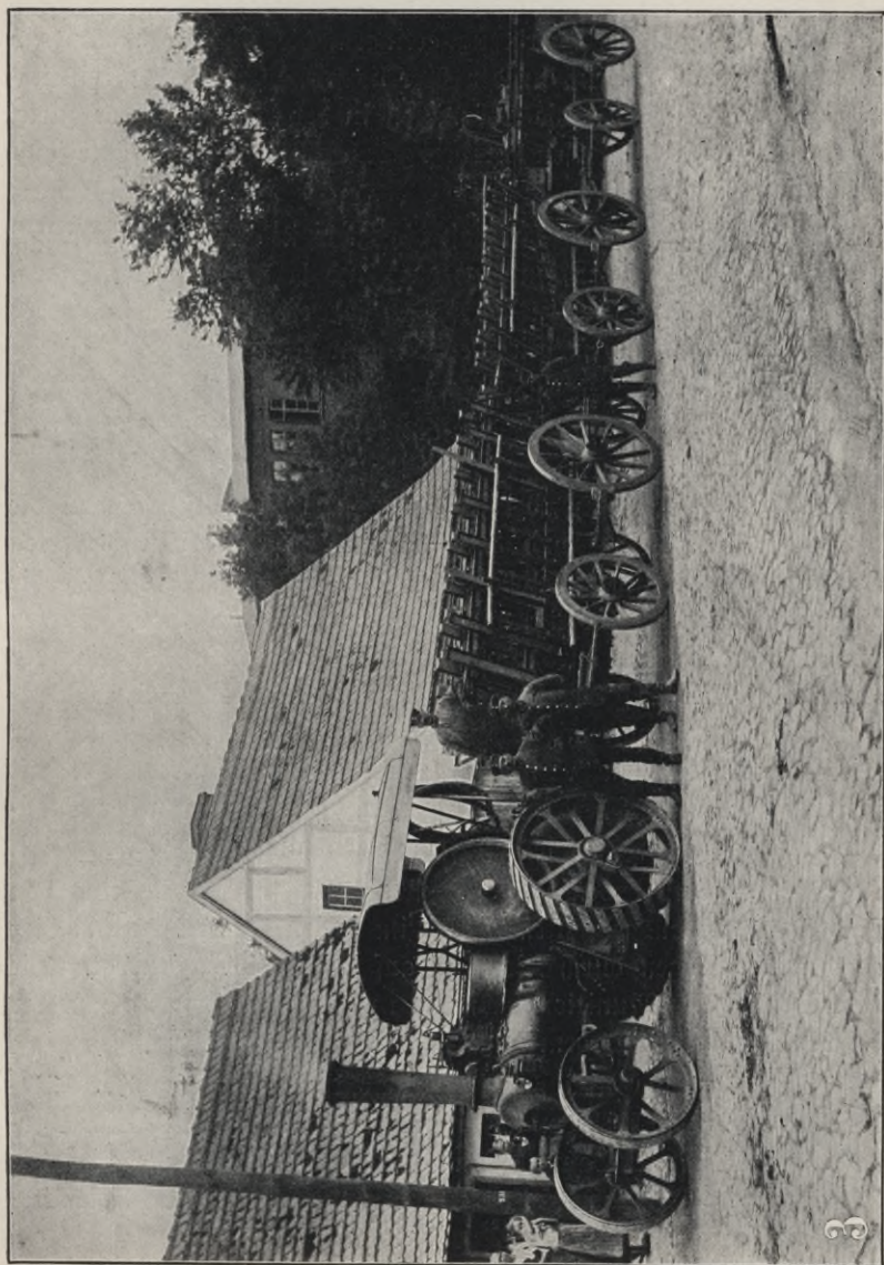
Abbild. 25. Militär-Straßenlokomotive, Type Maffa, von John Fowler & Co. in Magdeburg, Eisenbahnbau-Material transportierend.
