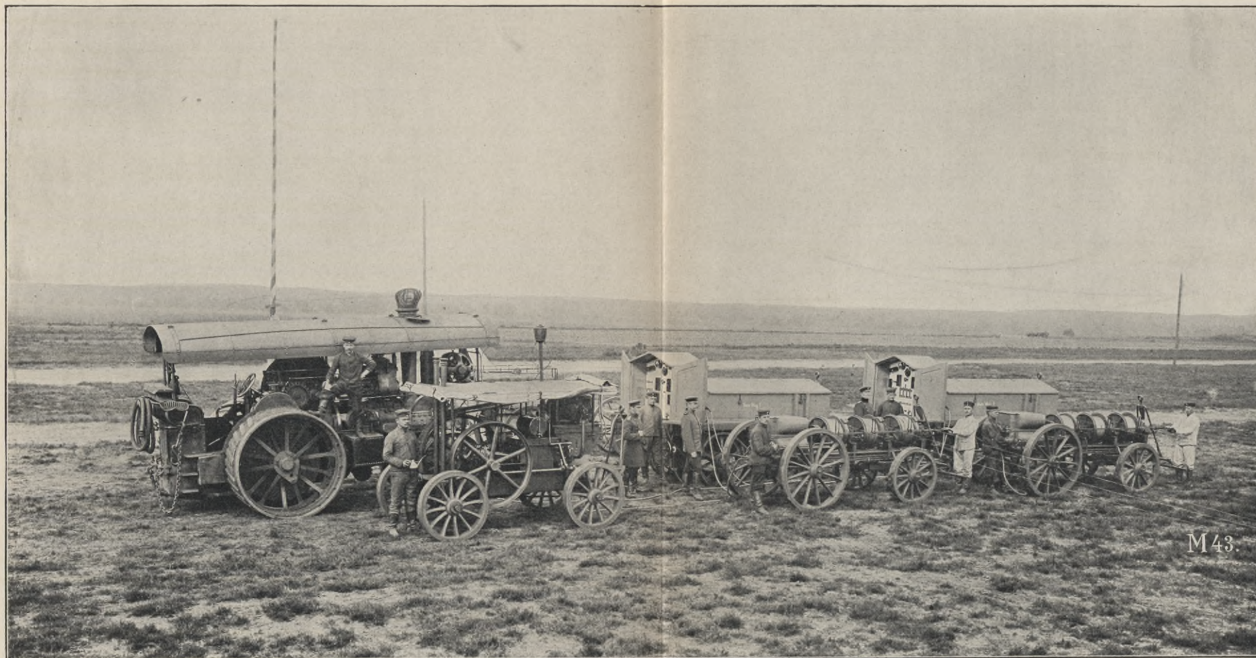
Militär-Straßenlokomotive von John Fowler & Co. in Magdeburg beim Betriebe des elektrischen Schienenzugapparates auf dem Truppenübungsplatz in Munster in Hannover.
