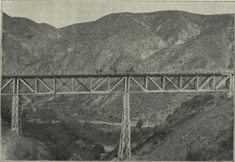
Abb. 616. Turmpfeiler des Yaila-Viadukts (Anatolische Eisenb.). D. B. Z. 1904 S. 420.
