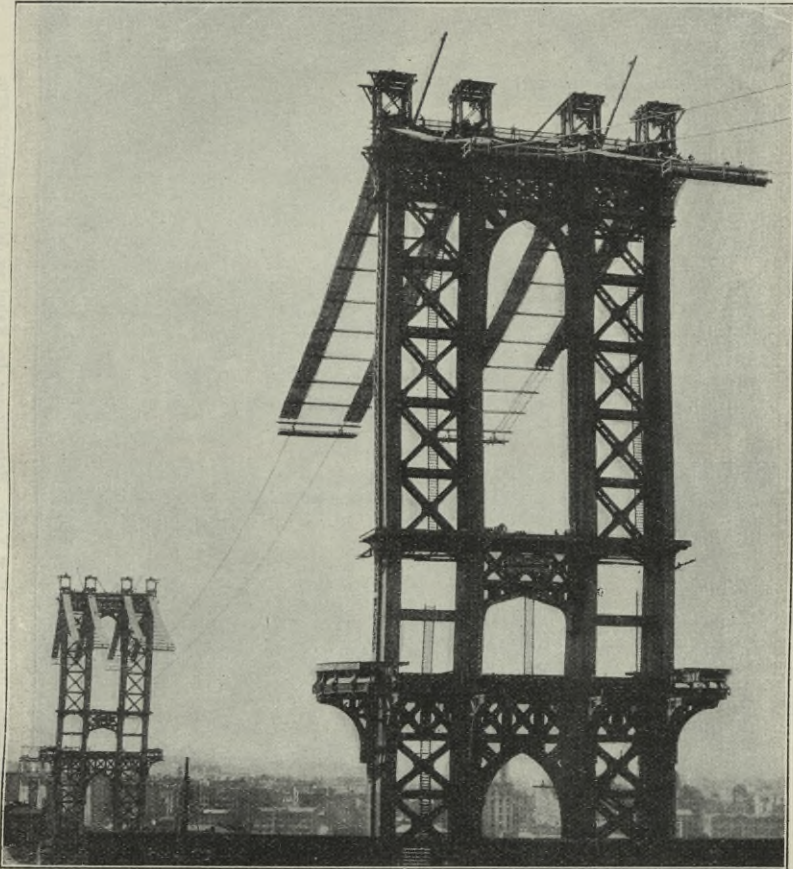
Abb. 369. Herstellung des Arbeitssteiges an den Hilfsdrahtseilen. Manhattan-Brücke.
