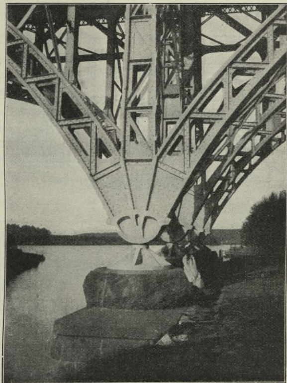
Abb 406. Auflager der Stößensee-Brücke bei Berlin.
