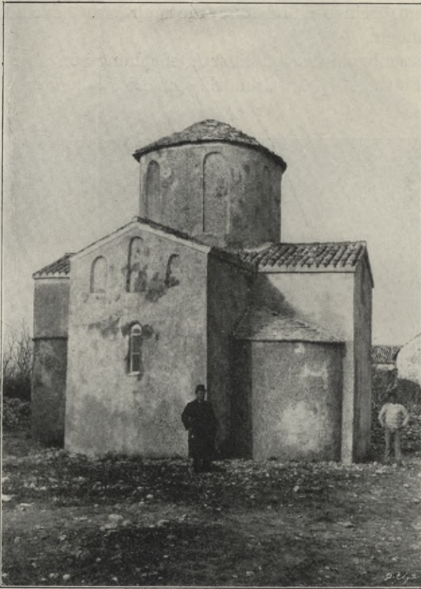
Phot. Nr. 4. Nona. Santa Croce, Apsidenanlage.
