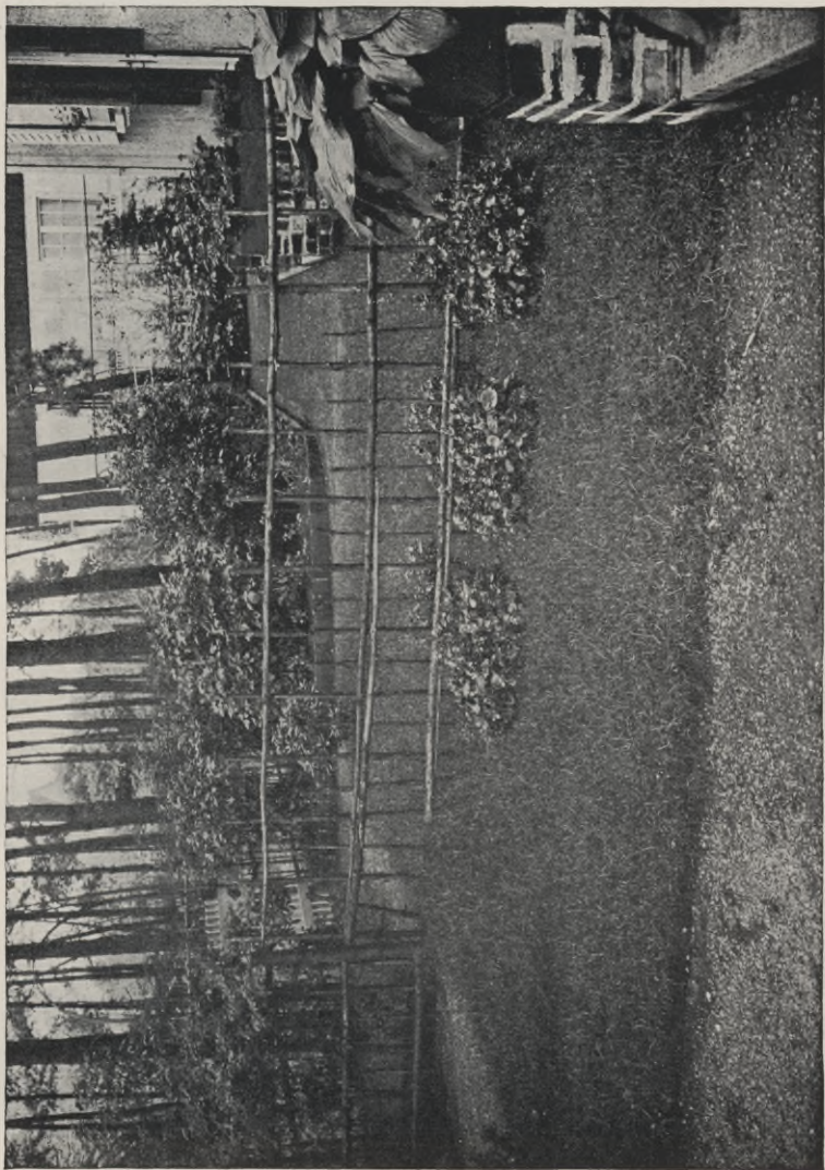
Gronauer Wald. Säulgruben der Versuchsanlagen Nr. 89 und 90. Die Struben sind bis auf die eisernen Deckel mit Käfen bewachsen. Die Deckel selbst sind, da sie der Verjüchung wegen häufig geöffnet werden müssen, mit Blumenkästen, die sich leicht abheben lassen, überdeckt. Das Bild zeigt, daß auch „Verjüchsanlagen“ dem Zuge wohlgelällig gefaltet werden können. Eine Geruchsbelästigung findet ebenfalls nicht statt.
