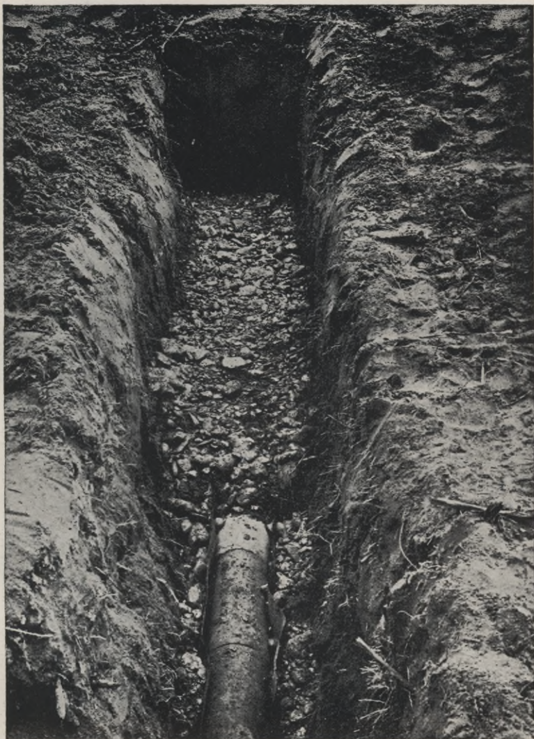
Drainrohrgraben einer im Bau befindlichen Untergrundrieselungsanlage im Gronauer Wald. Die Drainrohre liegen in einer 25 Centimeter starken Kiespackung. Rechts und links der Rohre sind die Asphaltpappstreifen sichtbar, die die Stoffugen vor der seitlichen Verschlämmung schützen. Die Rohre sind aus gelbem Ton, 30 Centimeter lang, 10 Centimeter lichte Weite.
