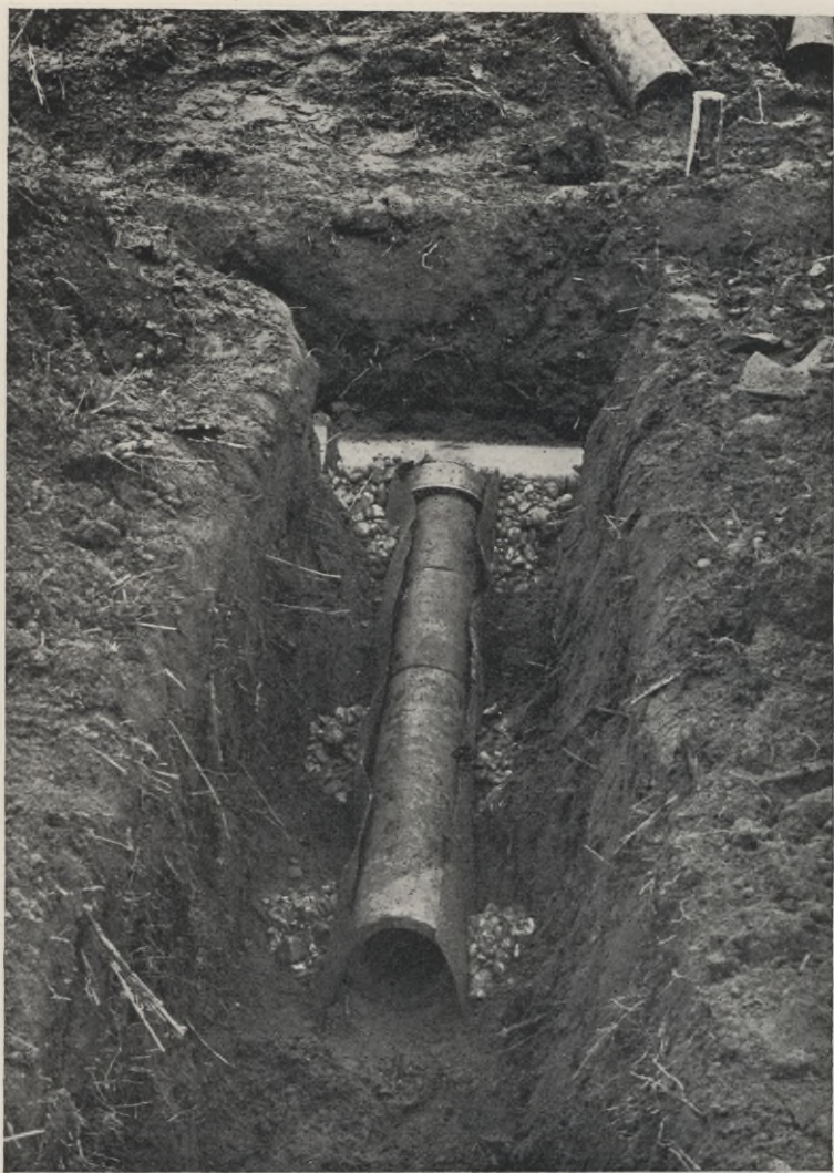
Abzweigstelle einer Untergrundrieselung von dem Verteilungsstrang. Der Verteilungsstrang besteht aus glasierten Tonrohren, deren Muffen mit Zement gedichtet werden. Zustand vor Einbringen des Kiefes.
