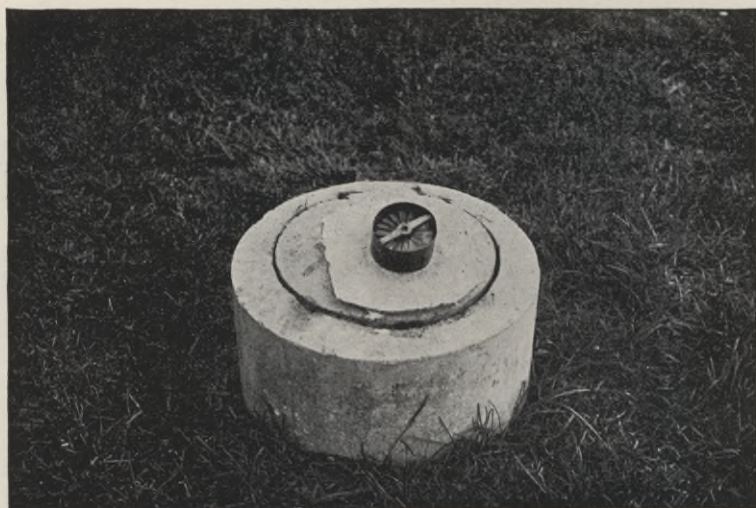
Luftschacht mit aufgesetztem Windrädchen.
