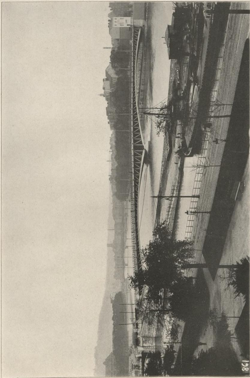
das andere ausgeglichen werden. Diese völlig ungebrauchliche Anordnung, die zu einer sehr schweren Konstruktion geführt hat, war geboten durch die kurze für die Herstellung verfügbare Frist, da es zu der Lütticher Ausstellung im Jahre 1905 in Gebrauch genommen werden sollte; dieser Zeitraum erlaubte nicht, den Pfeiler der alten Brücke neu zu bauen, der nicht in der Lage war, Horizontalschübe auszuhalten.
