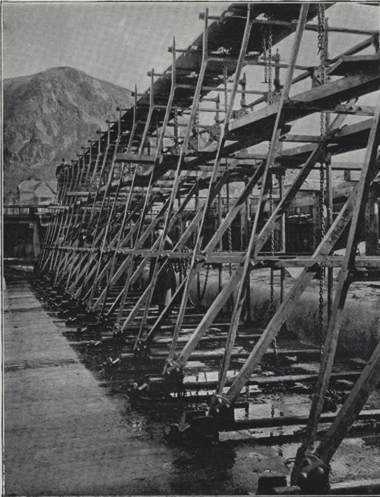
Abb. 17. Montirung des Nadelwehres bei Klecan im I. Wehrtheile, am 8. Februar 1898.
