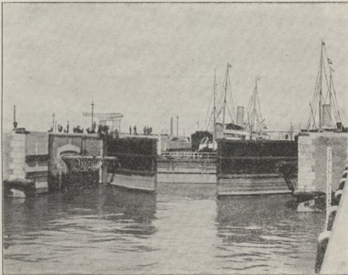
Aussenhaupt der grossen Kaiserschleuse in Bremerhaven.
