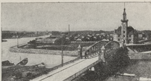
Stadthafenbrücke und Hafenampt in Dortmund.
