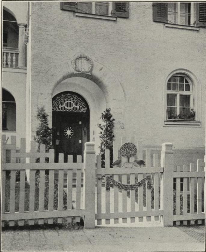
Hessemer & Schmidt, München: Eingangstür zu einem Mietwohnhaus in Landsberg a. L.
