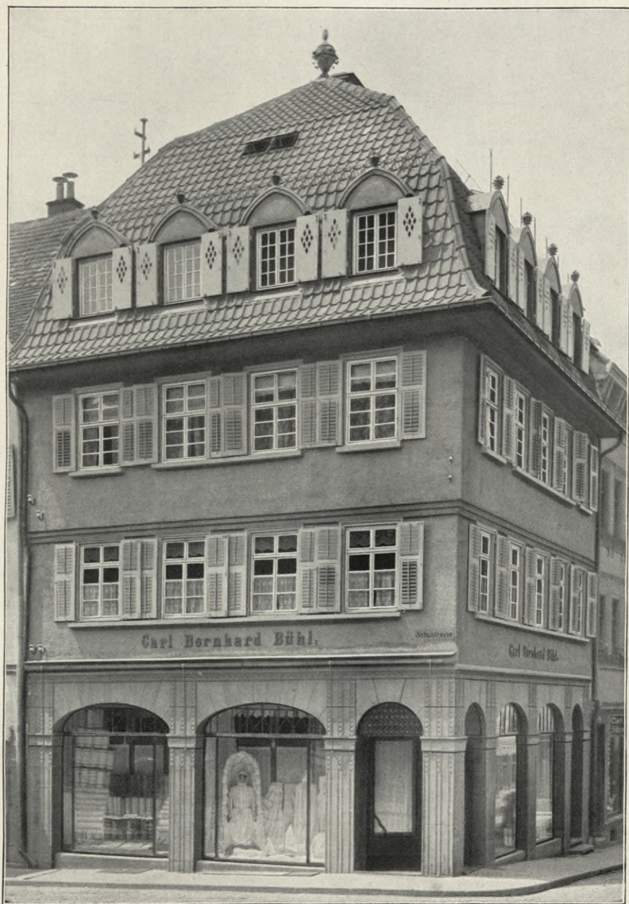
Theodor Hiller, Göppingen: Wohnhaus in Schwäbisch-Hall
