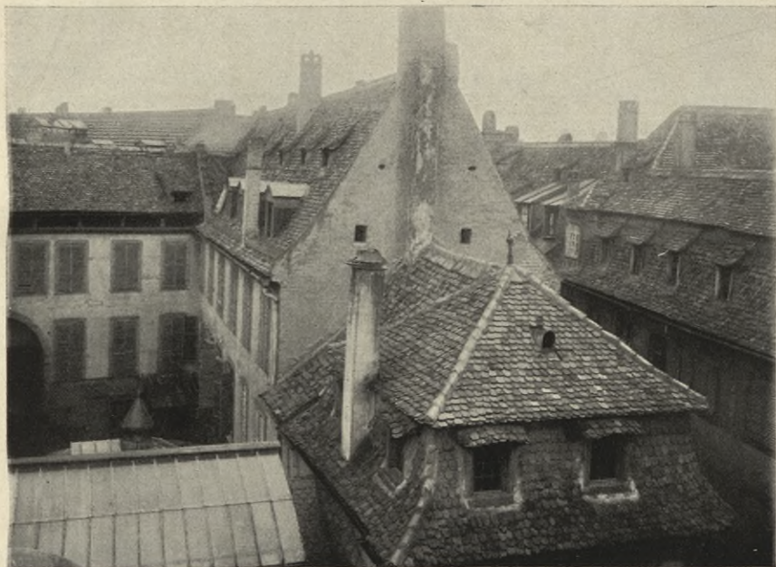
Ziegeldach in schöner Materialwirkung.
