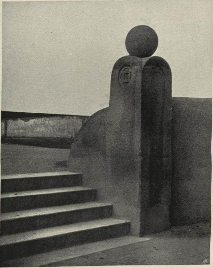
Architekturteile aus Stampfbeton in ge- schickter Material- behandlung.
