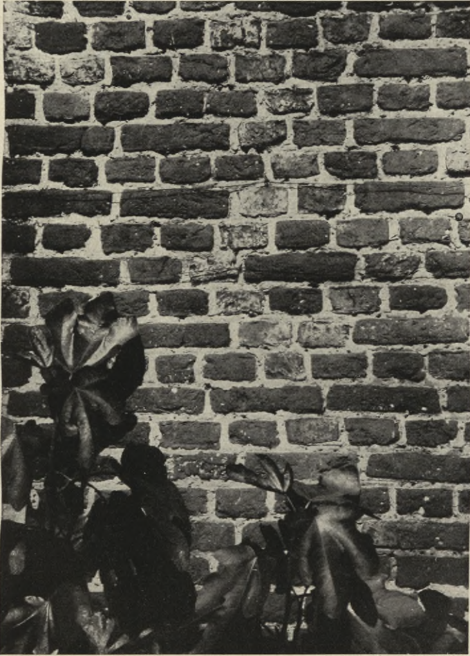
Rohziegelmauerwerk in guter Behandlung.
