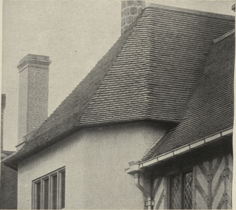
Ziegeldeckung mit Biber- schwänzen (Doppeldach).
