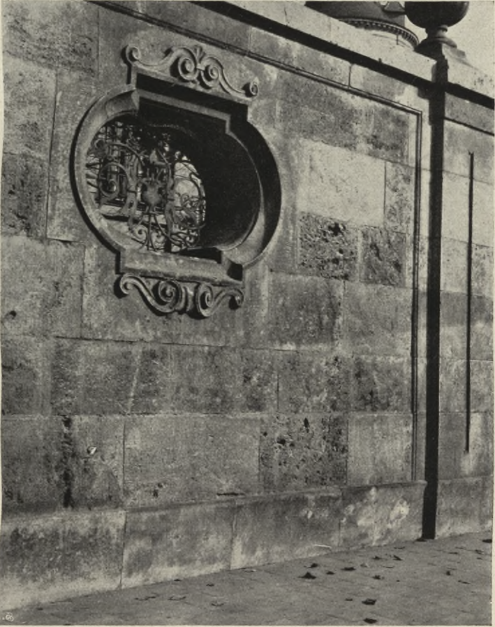
Werksteinmauer aus bayrischem Muschel- kalk.
