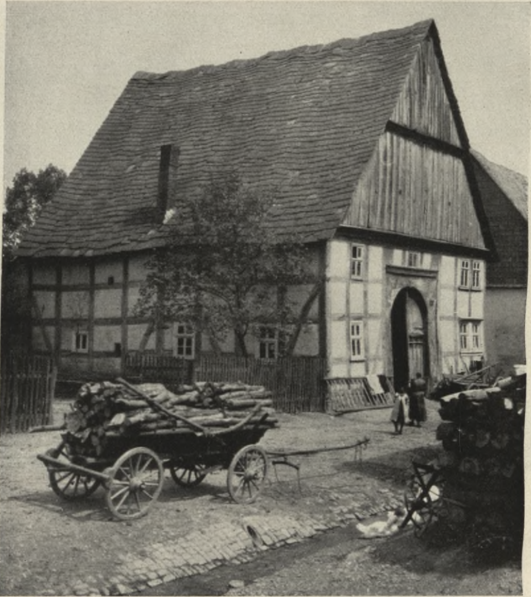
Dachdeckung aus Sand- steinplatten (hessisch).
